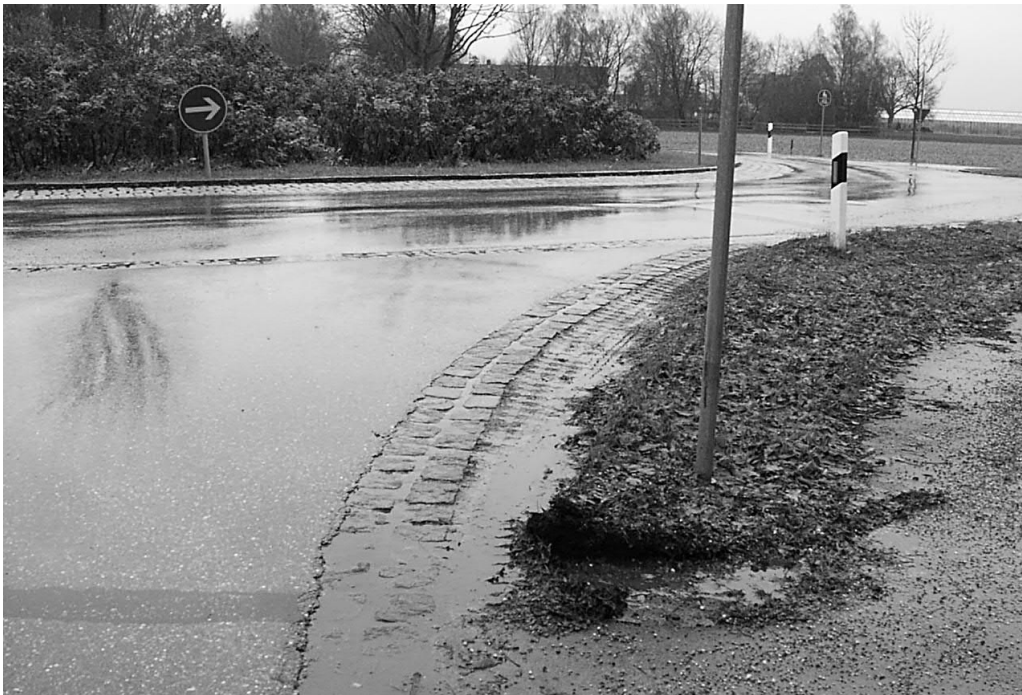
Abbildung 1: Beispiel für Fahrspuren neben der Fahrbahn; hier nachträgliche Fahrbahnverbreiterung mit Rasengittersteinen
