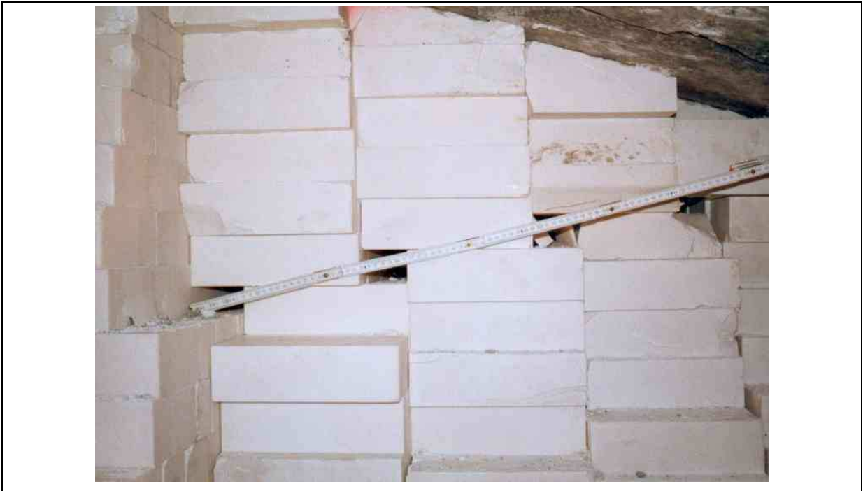
Abbildung B58: Rückbau des statischen Widerlagers: Vertikalschnitt der ersten 4 Schalen (luftseitig)
