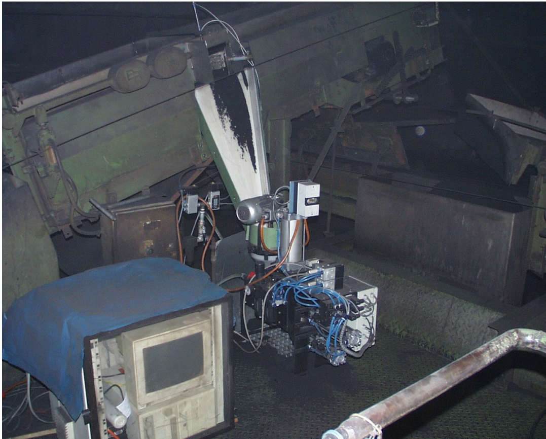
Abb. 112 : Anordnung des Verdichtbarkeitsmessgerätes zur Überwachung des Fertigsands
