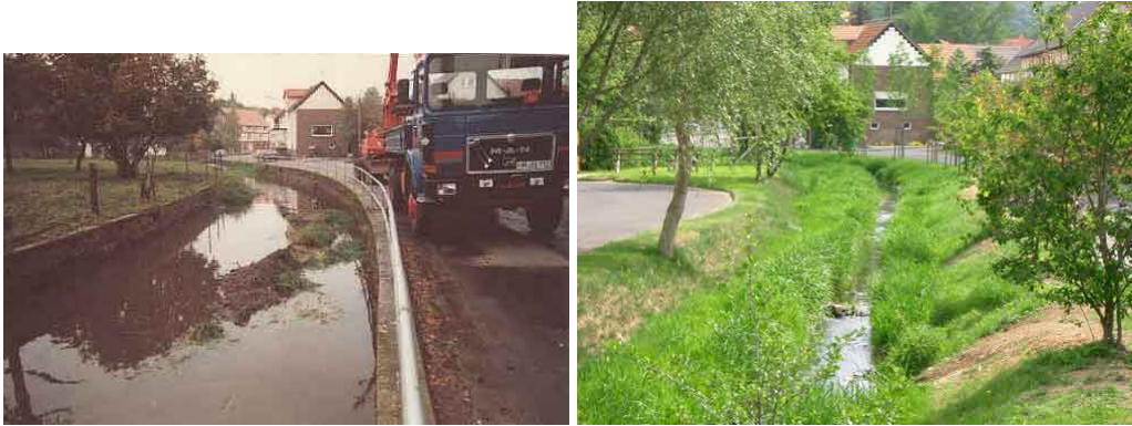
Abbildung B.10: Innerstädtische Maßnahme, bei der der Uferverbau entfernt wurde (Schwalm-Eder-Kreis, 2007)
