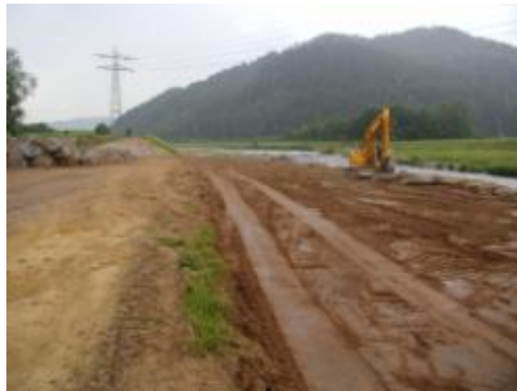
Abbildung B.21: Verdoppelung der Bettbreite durch Entfernung eines Vorlandes, Zustand während der Baumaßnahme (Kinzig bei Biberach (Zollwehr)) (River-Consult, 2007)
