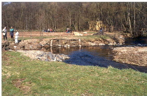
Abbildung B.7: eingegrabene Wurzelstöcke (LfU BW, 2002a)
