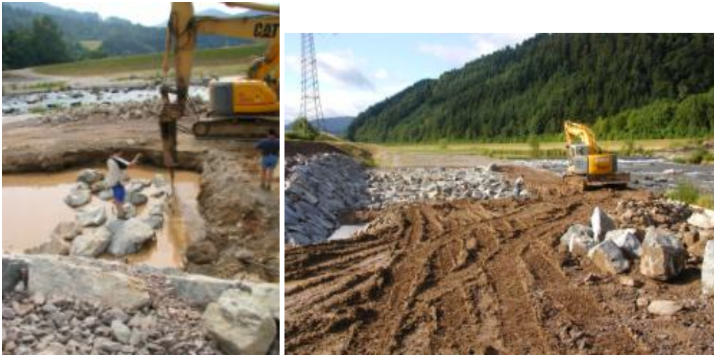
Abbildung B.26: Bau einer Übergangsrampe vom Vorland zur neu gestalteten Sohle - Zustand während der Baumaßnahme (Kinzig bei Biberach (Zollwehr)) (River-Consult, 2007)
