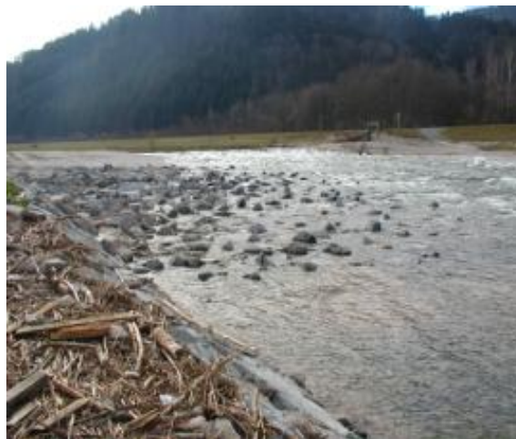
Abbildung B.27: Zustand nach der Baumaßnahme (River-Consult, 2007)
