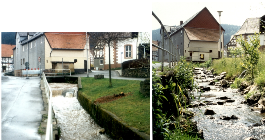
Abbildung B.9: Zustand vor und nach dem Rückbau von Uferverbau (LfU BW, 2002a)
