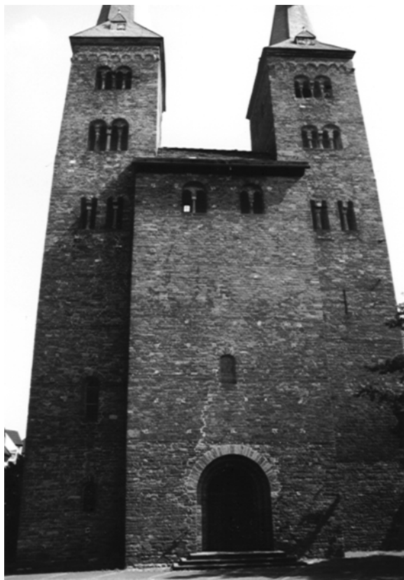
Abbildung 56: St. Kilian, Höxter, Ansicht von Westen. Knickende Fluchtlinien der Türme zwischen 4. Und 5. Turmgeschoss. – Verf.
