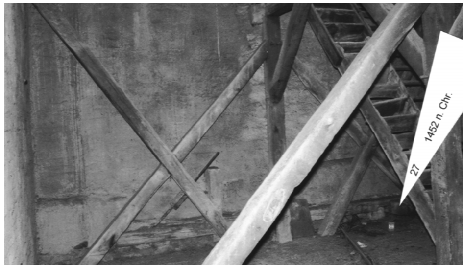
St. Kilian: Mittelbach des Turmwerks, 3. Geschoss, Blick nach Norden
