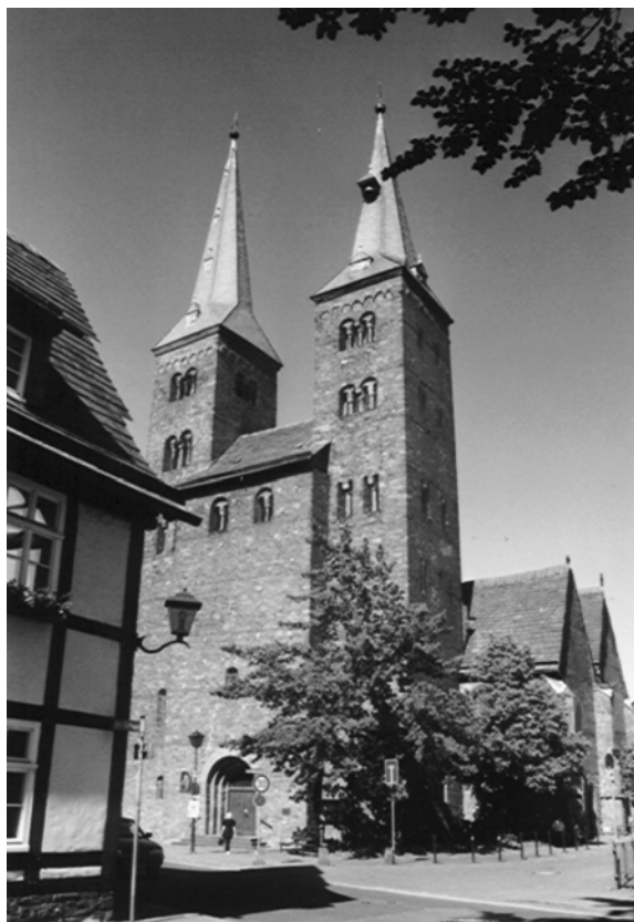
Abbildung 57: St. Kilian, Höxter, Ansicht von Südwest.
