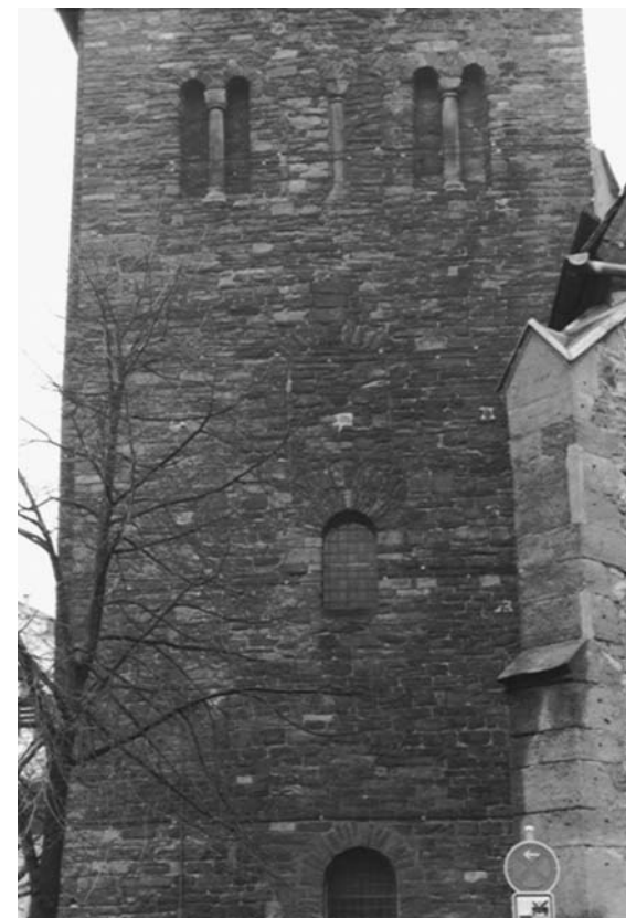
Abbildung 58: St. Kilian, Höxter, Südturm von Süden. Zugesezte Mauerwerksöffnung mit Segmentbogen zwischen Säulengalerie und Rundbogenfenster. – Verf.
