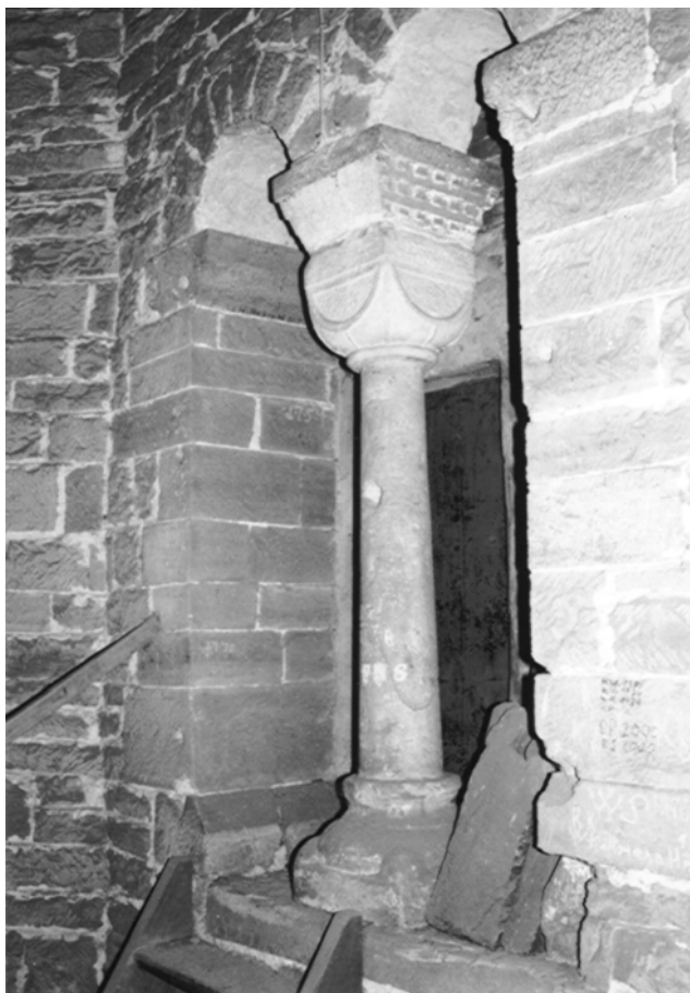
Abbildung 30: Klosterkirche Marienmünster, Säule des Vierungsturmes, Innenansicht. – Verf.
