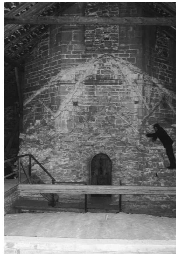
Abbildung 29: Klosterkirche Marienmünster, Ansicht des Vierungsturmes mit alten Dachlinien von Westen. – Verf.
