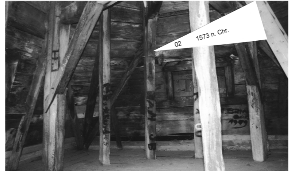
St. Kilian: südliches Turmdach, Blick nach Nordosten
