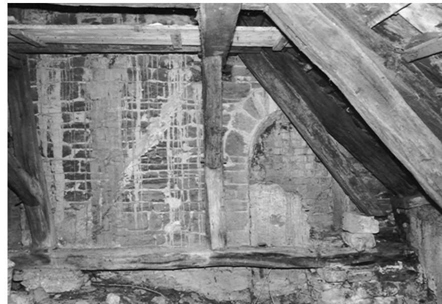
Abbildung 60: St. Kilian, Höxter, Blick gegen das Mittelschiff im Bereich der westlichen Dachhälfte des südlichen Seitenschiffs. Spur eines älteren Dachanschlusses. – Verf.
