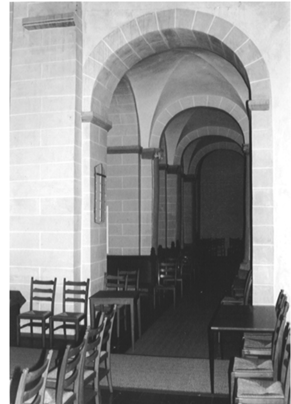
Abbildung 75: St. Kilian, Höxter, Blick vom nördlichen Querarm in das nördliche Seitenschiff. – Verf.
