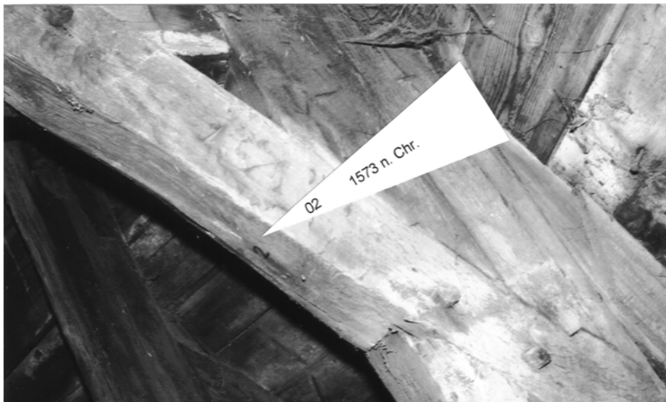
St. Kilian: südliches Turmdachwerk, Kopfband
