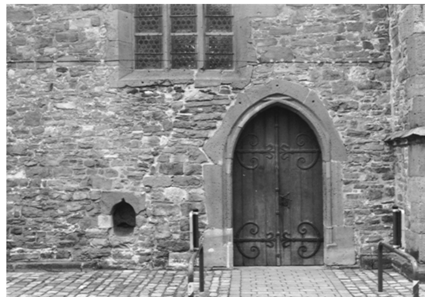
Abbildung 62: St. Kilian, Höxter, Portal zum südlichen Seitenschiff, Außenansicht. – Verf.
