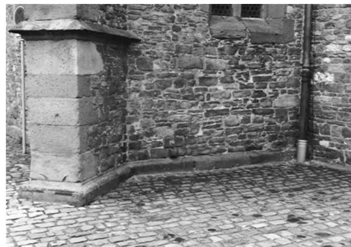
Abbildung 79: St. Kilian, Höxter, südliches Seitenschiff. Außenansicht der östlichen Außenwand. – Verf.
