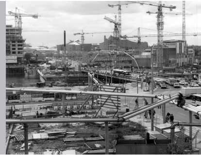
Abb.7.1: Baustelle Potsdamer Platz, Berlin, Mai 1997
