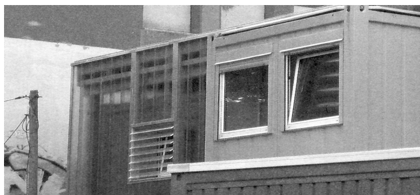
Abb.5.16-18 : Bed by night : Baukonstruktion aus Containern, Holztragwerk und Industrieglasfassade
