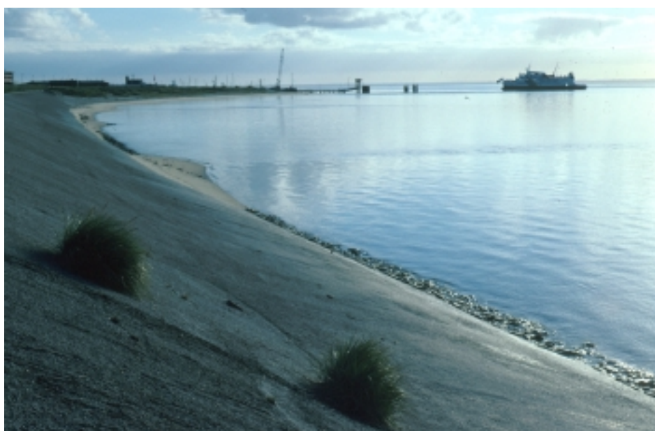
Abbildung 8-14: Mit Asphalt überdeckte Steinschüttungen schützen das Wattufer im Dorf List.
