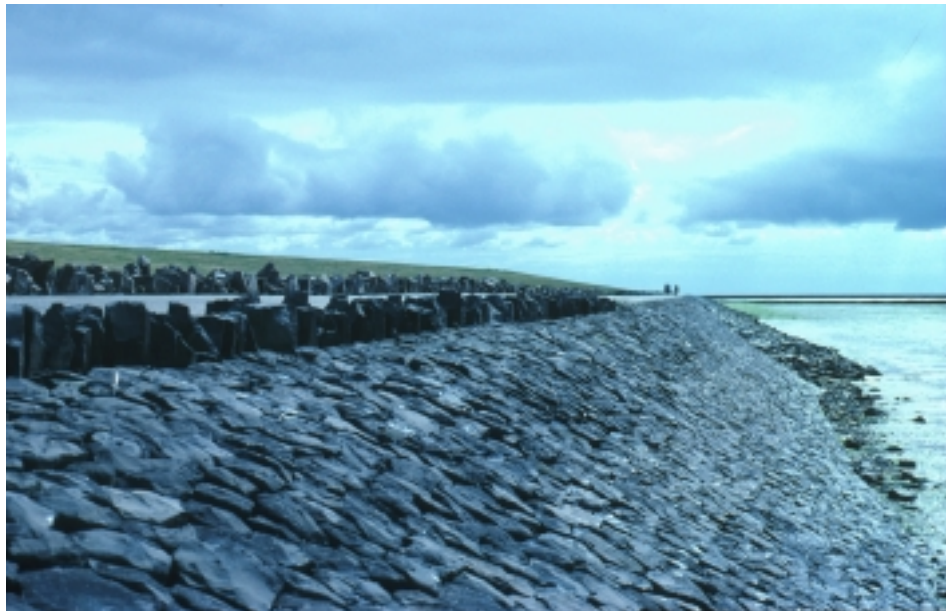
Abbildung 8-6: Deichfuß mit Basaltsteinen südlich Morsum, an den sich übergangslos ein Sandwatt anschließt.
