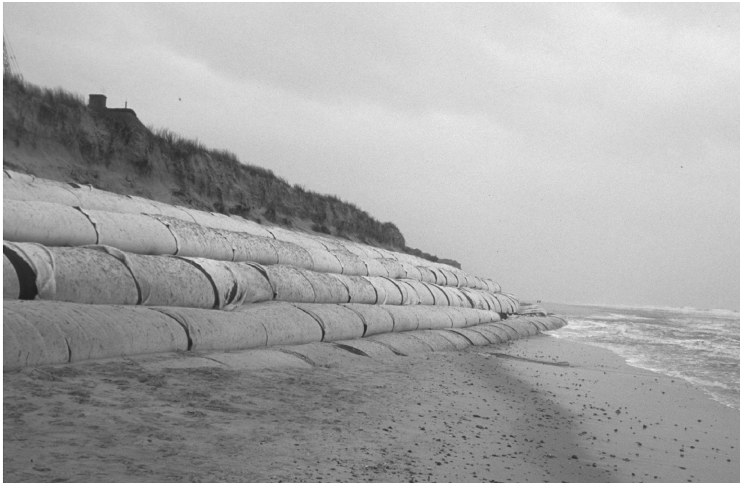
Abbildung 7-20: Geotextiles Deckwerk vor dem Haus Kliffende / Kampen (Zustand: Feb. 2000)
