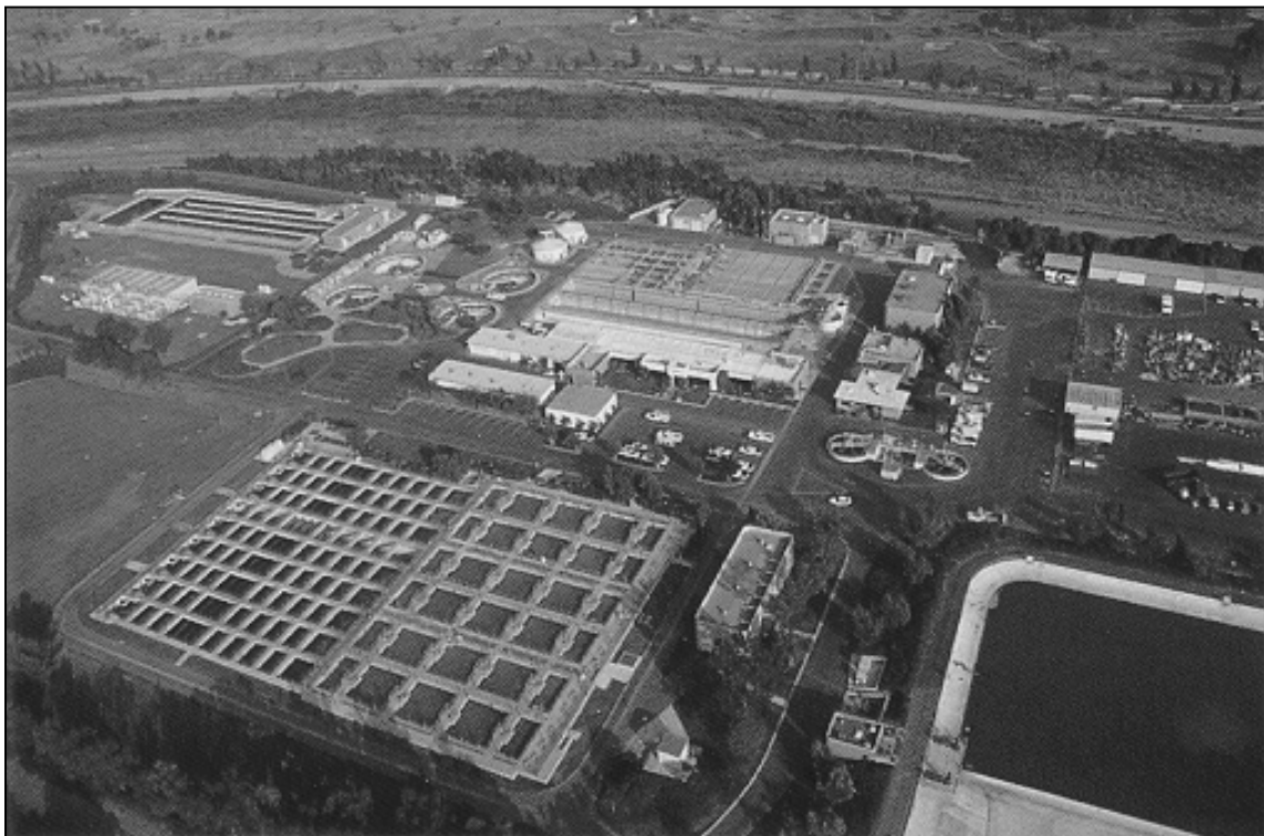
Abbildung 34: Kläranlage in Irvine (Quelle: Irvine Ranch Water District)
