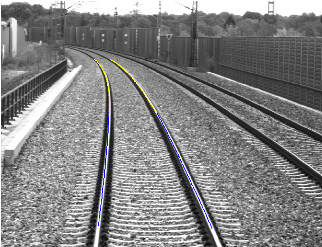
Abbildung 13 Gleisverlauf mit zwei geschätzten Modellen. Die Vorausschau beträgt hierbei etwa 200 Meter.
