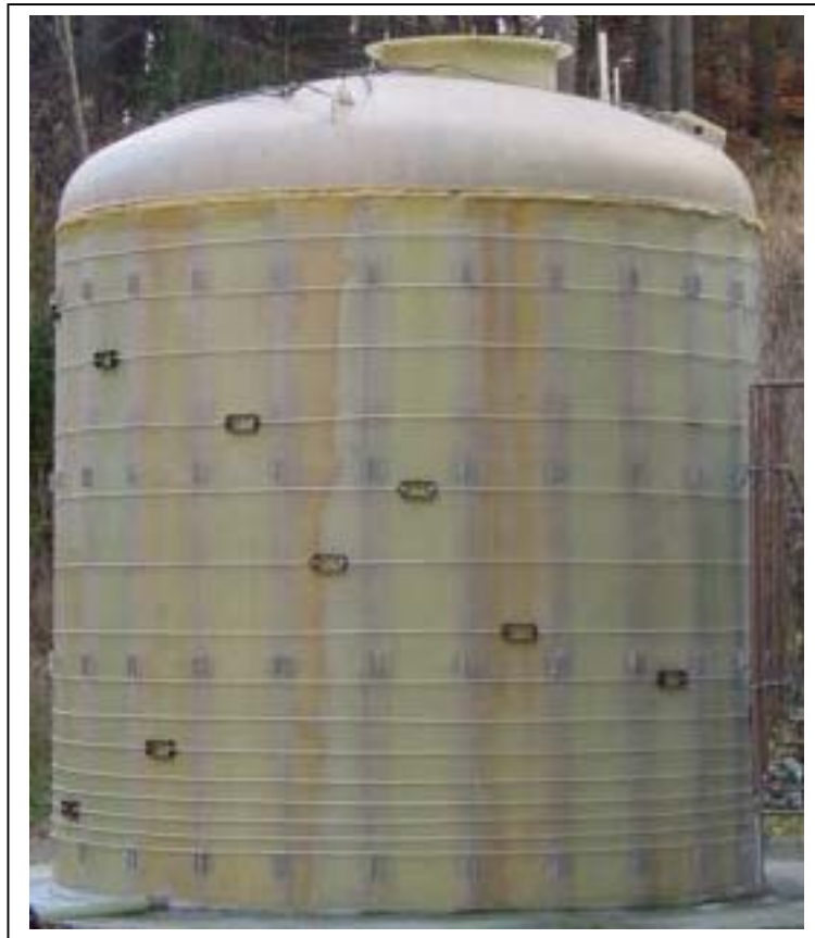
Abbildung 38: Fertig gestellter 20 m 3 GFK – Musterspeicher NT in Schönbrunn
