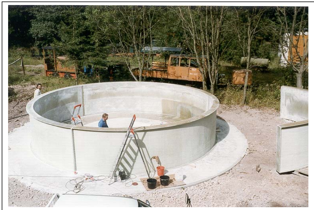
Abbildung 19: Aufbau des ersten Ringes
