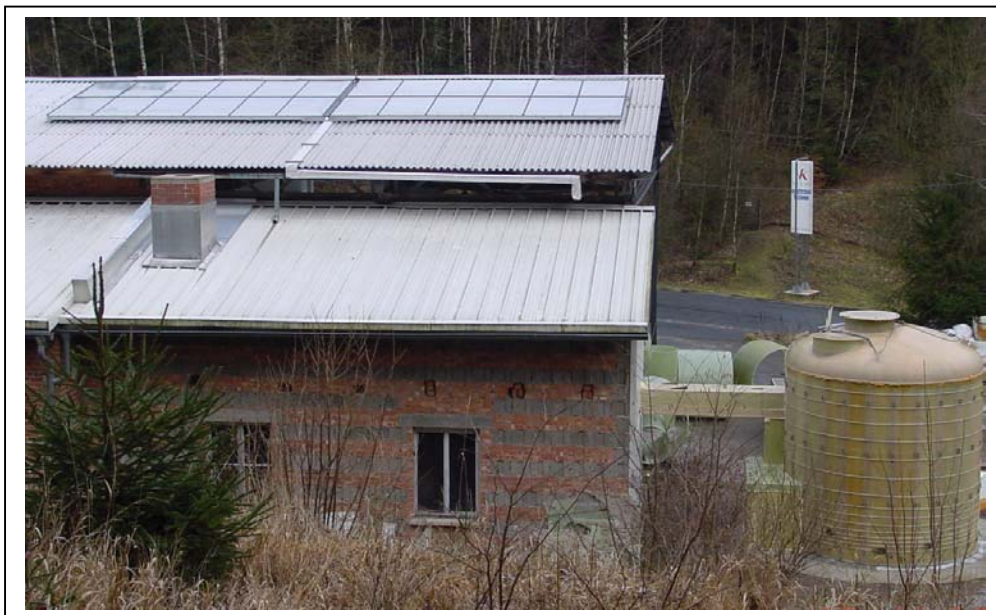
Abbildung 39: Musterspeicher und 30 m 2 Kollektorfeld
