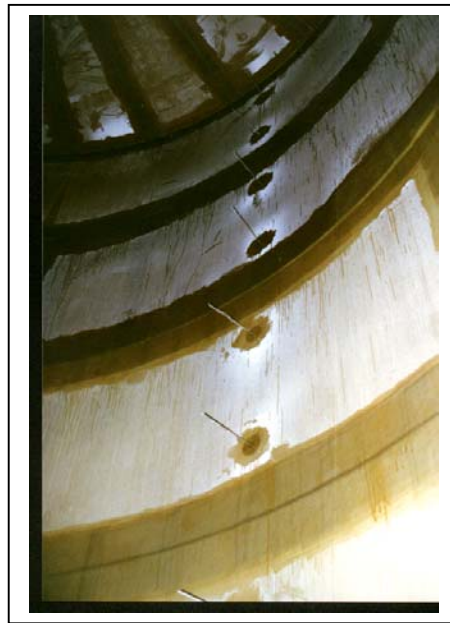
Abbildung 26: Temperaturmessstellen im Speicher (500 mm Tauchhülsen)
