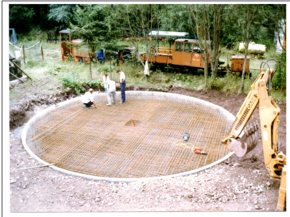
Abbildung 18: Fundamentaufbau mit umfangreicher Stahlarmierung
