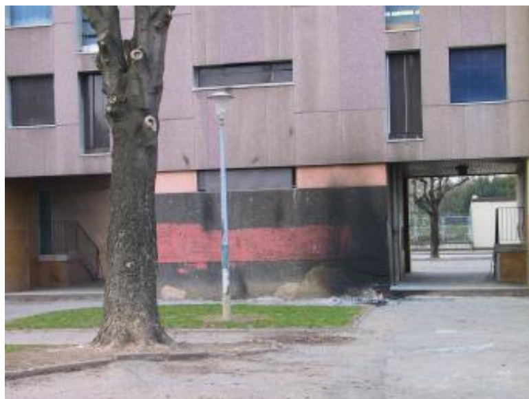
Vandalismus in der Rue Becquerel
