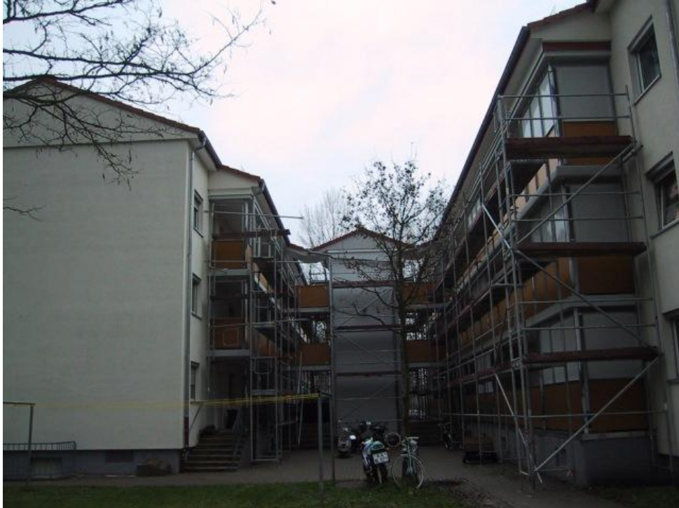
In Renovierung befindlicher Wohnblock „Kleinseeäcker“
