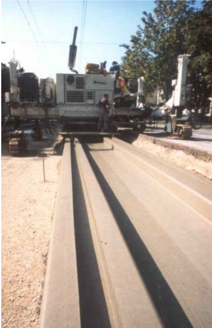
Abbildung A-7: Gleitschalffertiger beim Herstellen der Betontragplatte
