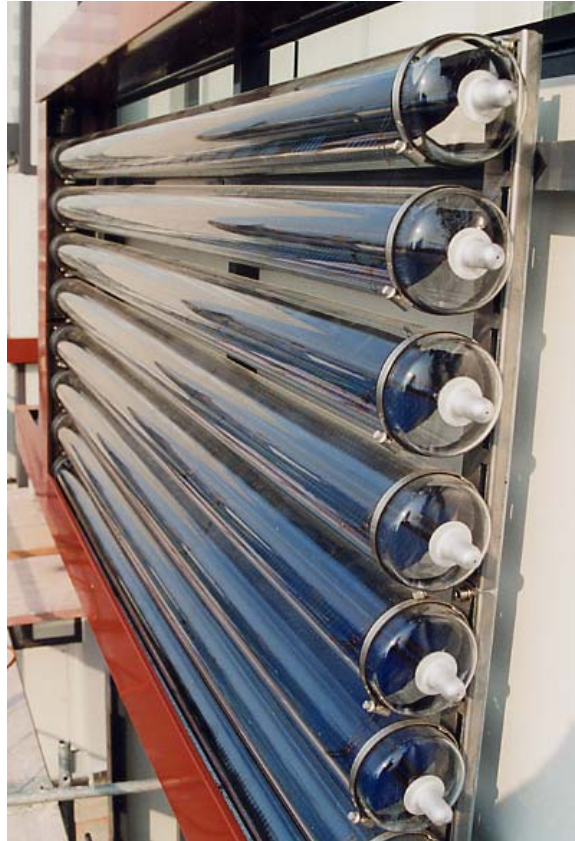
Teilansicht eines montierten Balkonmoduls. Die Verkleidungen sind fertiggestellt. (Foto: TU I / FG TFD 01)
