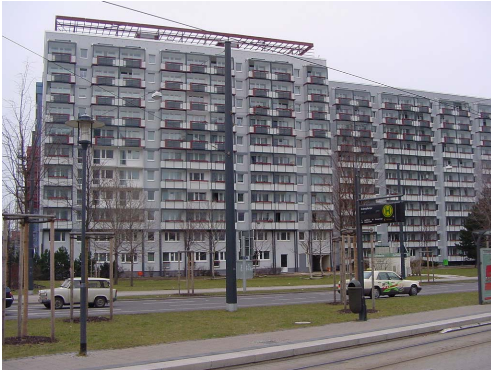
Gesamtansicht des Gebäudes Juri-Gagarin-Ring aus südwestlicher Richtung ( Foto: TU I / FG TFD 01 )
