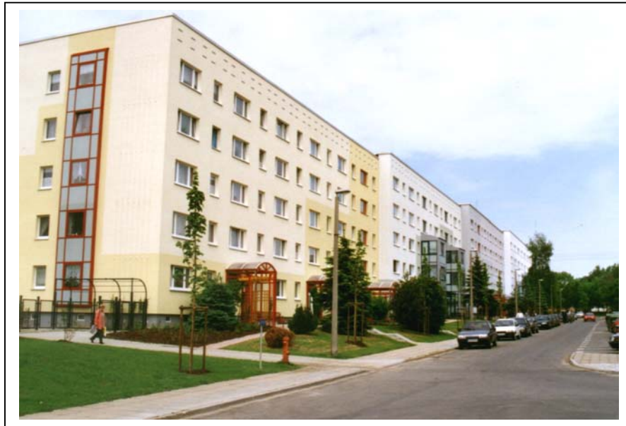
Ansicht der Wohngebäude Leinefelde
