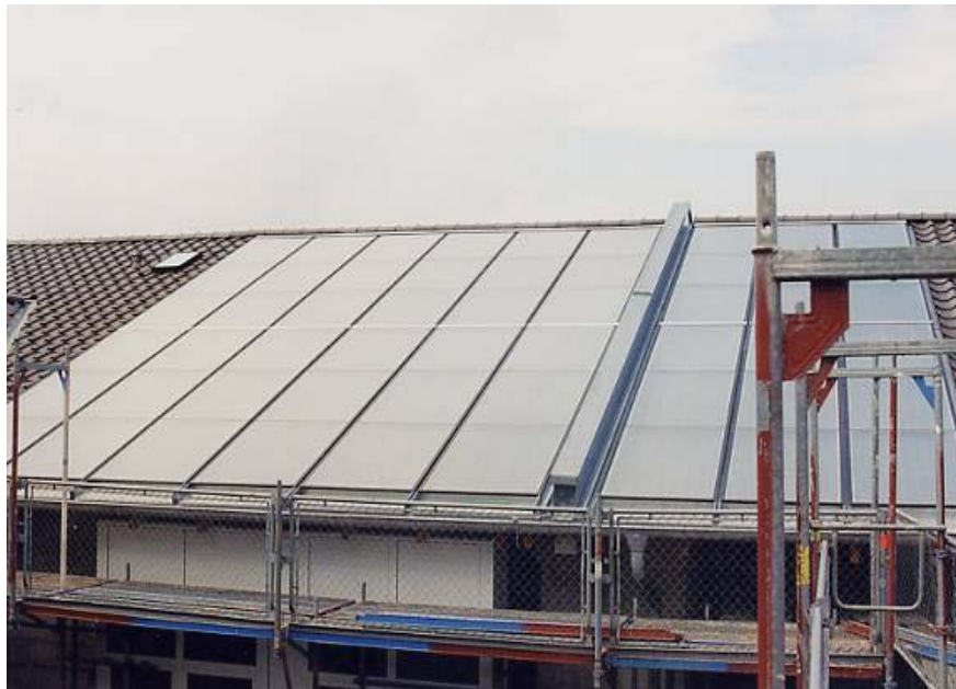
Ansicht des östlichen Teilfeldes auf dem Schrägdach des Neubaus ( Foto: TU I / FG TFD 2000)
