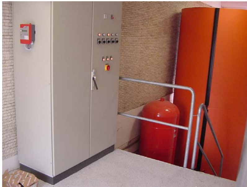
Ansicht des Mess- und Regelungstechnik - Schaltschranks im umgebauten ehemaligen zweiten Durchgang. Rechts ist der 10m 3 Pufferspeicher und das zugehörige Ausdehnungsgefäß zu sehen. (Foto: TU I / FG TFD 01)
