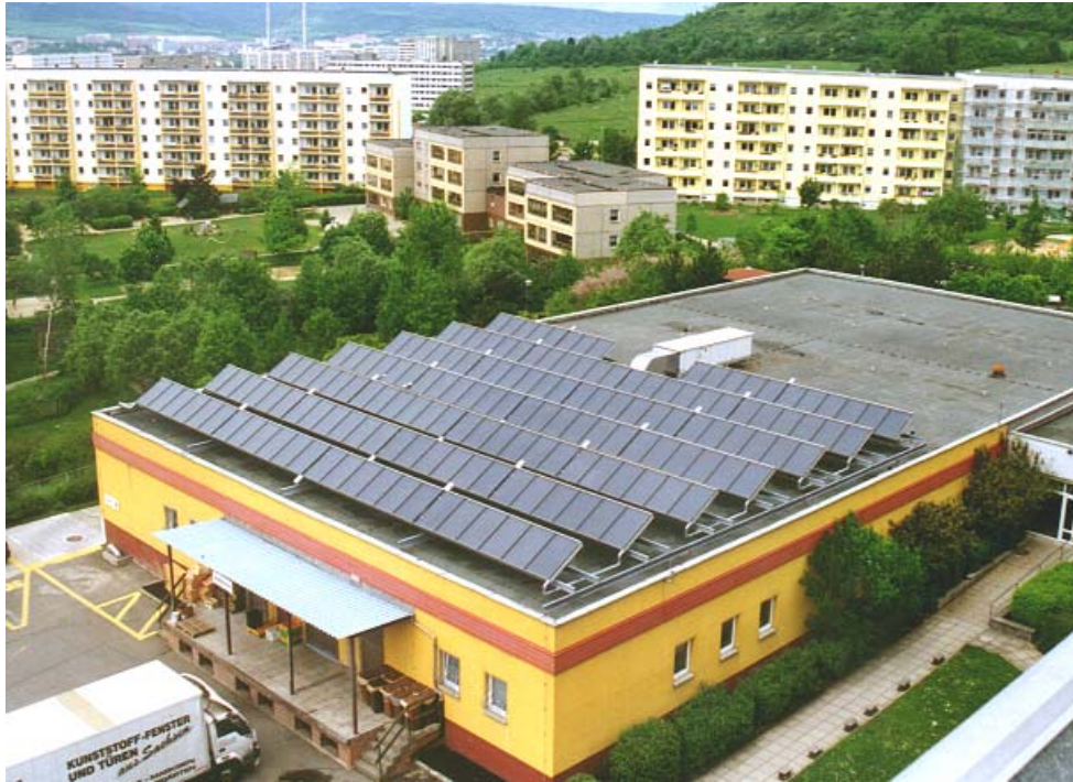
Gesamtansicht des Kollektorfeldes auf dem Dach des Versorgungstraktes
