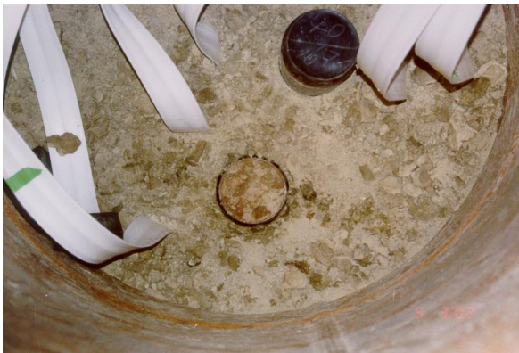
Bild 17 mittlere Bentonitschicht (-1,30 m) deutliche Zunahme der Feuchte
