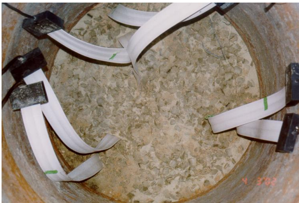
Bild 15 obere Sandschicht entfernt gesamte Fläche feucht (-1,12 m)
