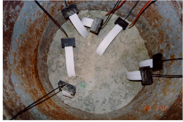
Bild 14 obere Bentonitschicht (-0,85 m) nur an den Kabeln feucht
