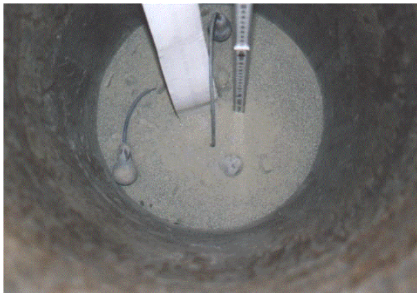
Bild 11.4 Keller-Druckkugeln und Kabelsensor (KU 7)
