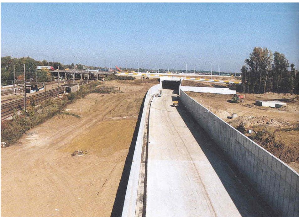
Bild 2-18: Bau eines Tunnels in offener Bauweise
