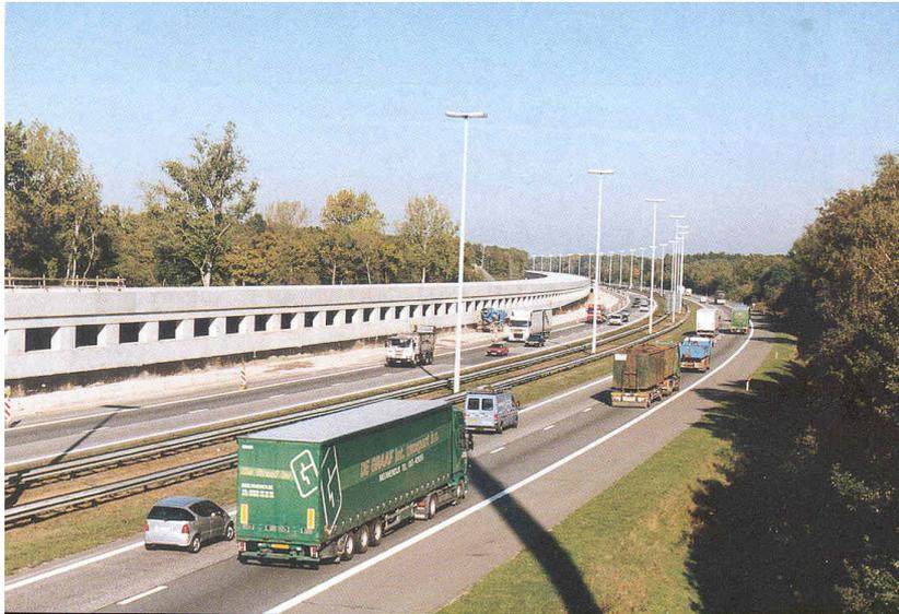
Bild 6-2: Ausführungsbeispiel für eine eingekapselt, oberirdisch verlegte Schienenbahn entlang einer Autobahn (HSL Antwerpen-Rotterdam, Inbetriebnahme 2007)
