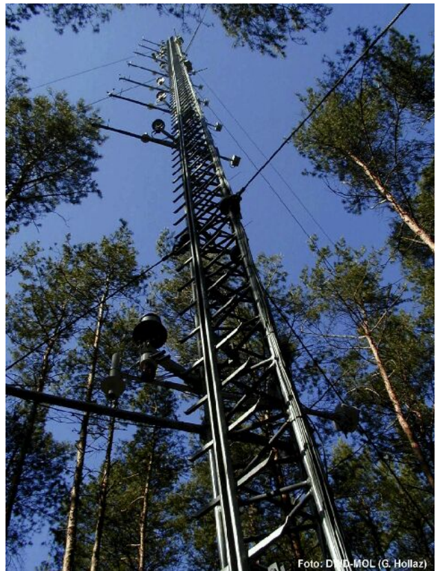
Abb. 3-4 Profilinstrumentierung des 30 m-Mastes in einem Kiefernforst bei Kehrigk nach der Neuerrichtung im Sommer 2002
