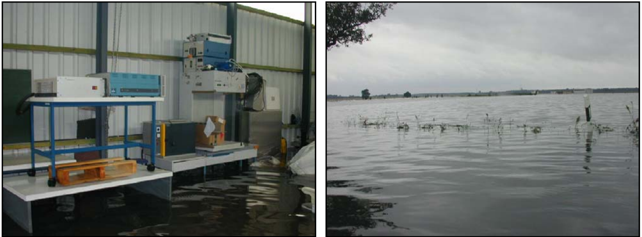
Abb. 7: Stand des Hochwassers am 14.08.2003 an der Ankerstation Melpitz. Links, gesicherte Messgeräte in der Ballonhalle und rechts Blick von der überfluteten Verbindungsstraße Melpitz – Klitzschen in Richtung Messfeld
