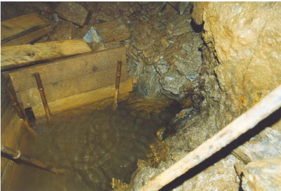
Bild 4.4: Sicherung der Versturzstelle im Querschlag QS 2002 gegen nachrutschende Masse
