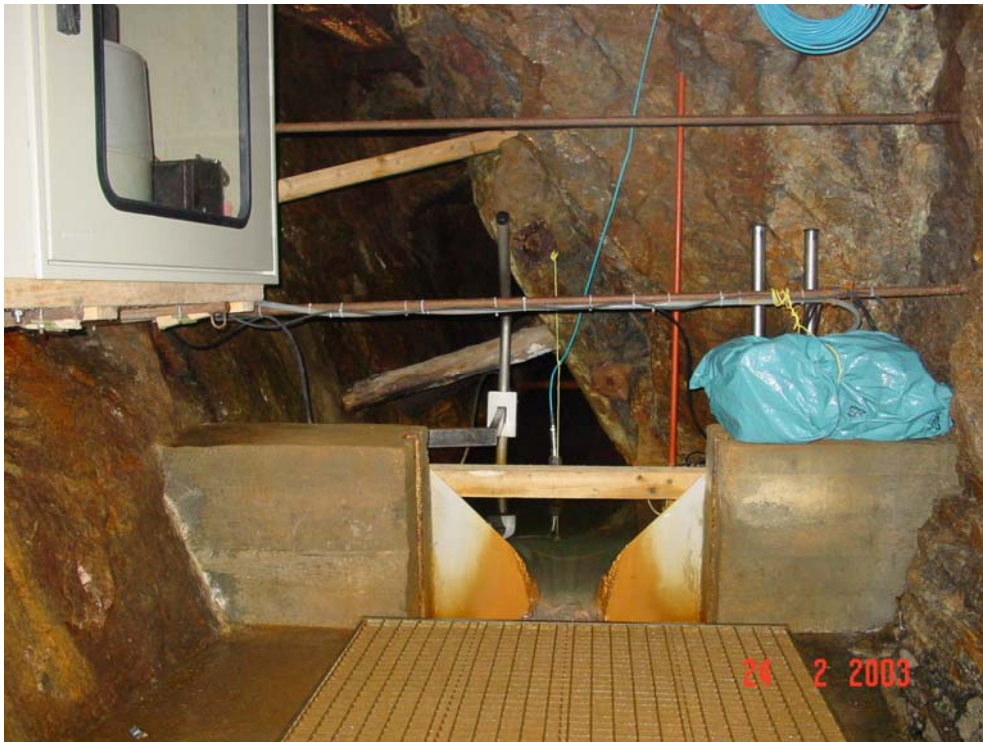
Bild 4.2: Grubenwasseraustritt am Gesenk 2. Sohle (Probenahmestelle SBÜ), Foto: Zinnerz GmbH
