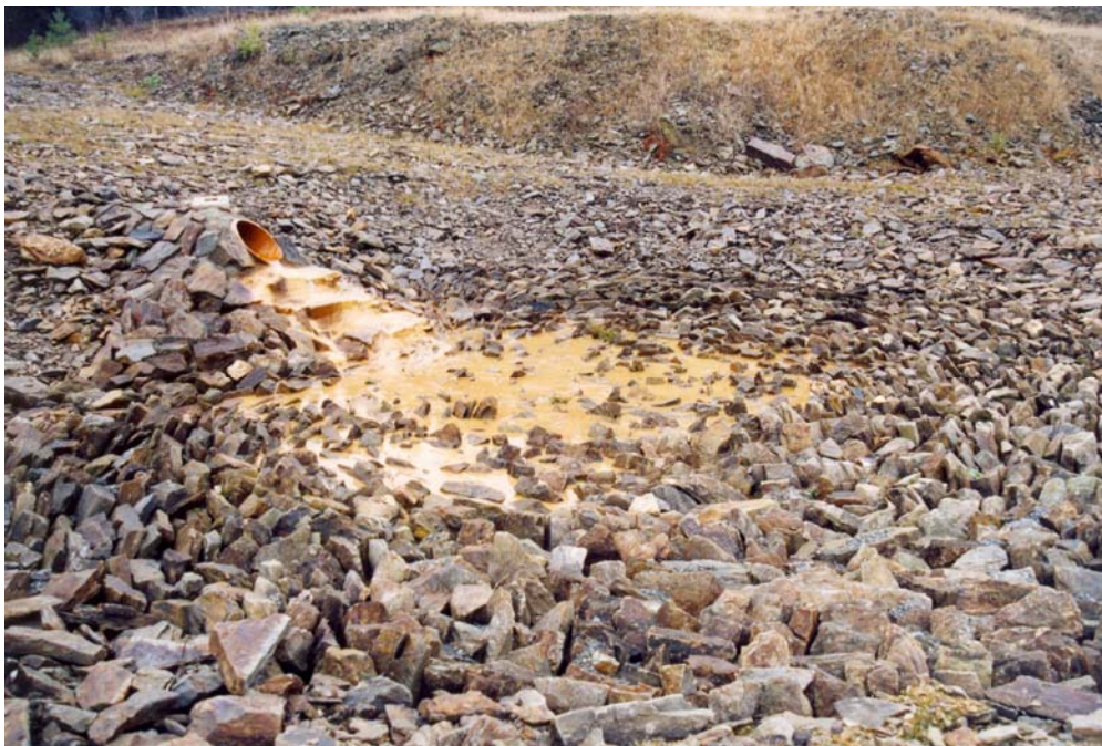
Bild 4.1: Versturzpunkt 28 im Bereich der Bruchzone, 04.12.2003
