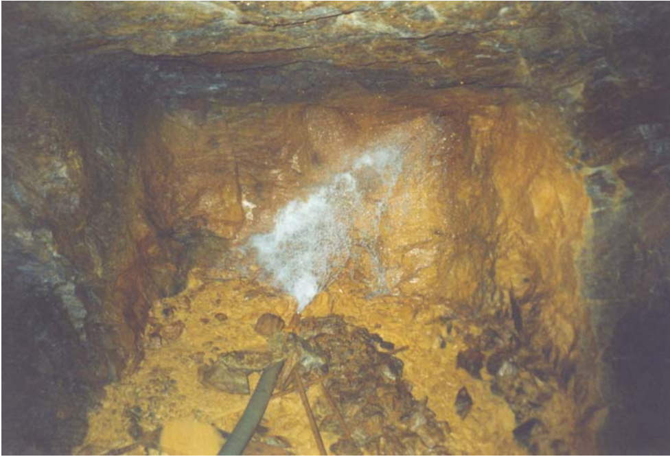
Bild 4.3: Sauerstoffanreicherung der aus dem Überhauen (ÜH 3-1314) gepumpten Wasser durch Verspritzen am Stoß
