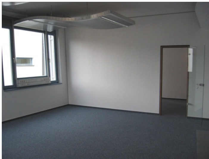
Bild 5.6: Büroraum mit Deckensegel.
