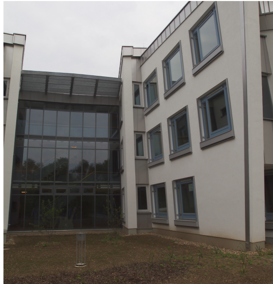
Bild 5.17: Statischer Sonnenschutz des Ausstellungsbereichs.
