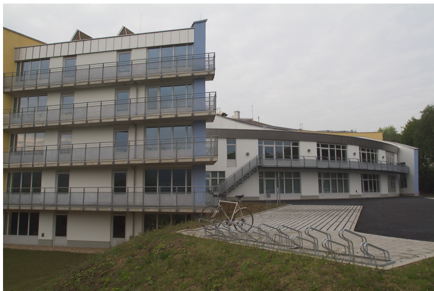
Bild 5.3: Nord – Ost Ansicht des Artur-Woll-Hauses, Gästehaus und Nordbau
