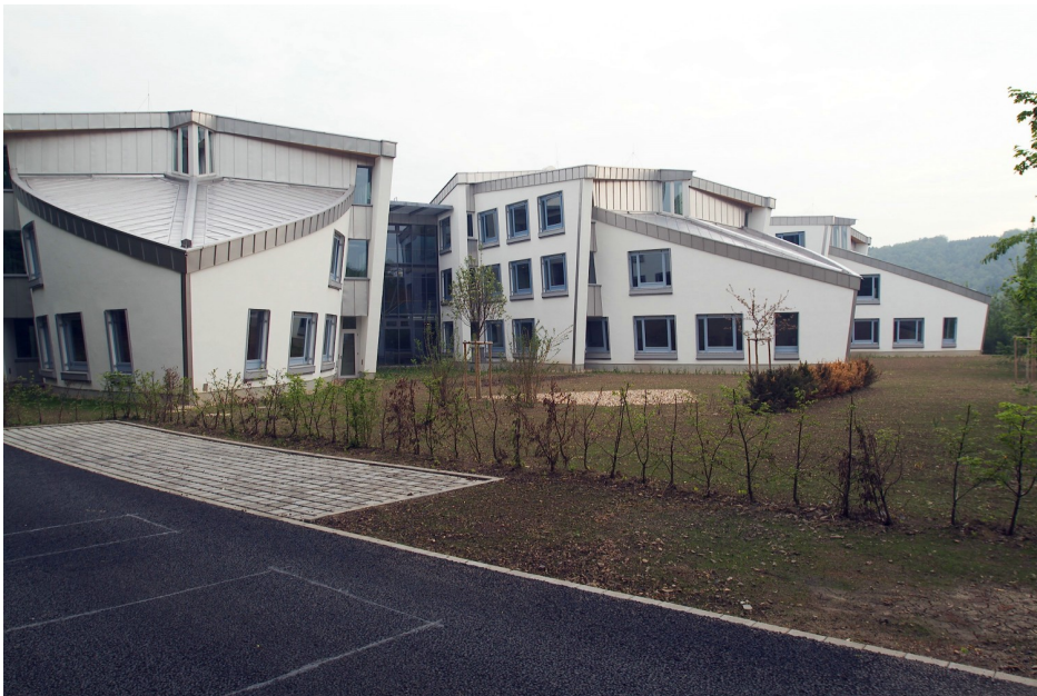
Bild 5.1: Süd – West Ansicht des Artur-Woll-Hauses
