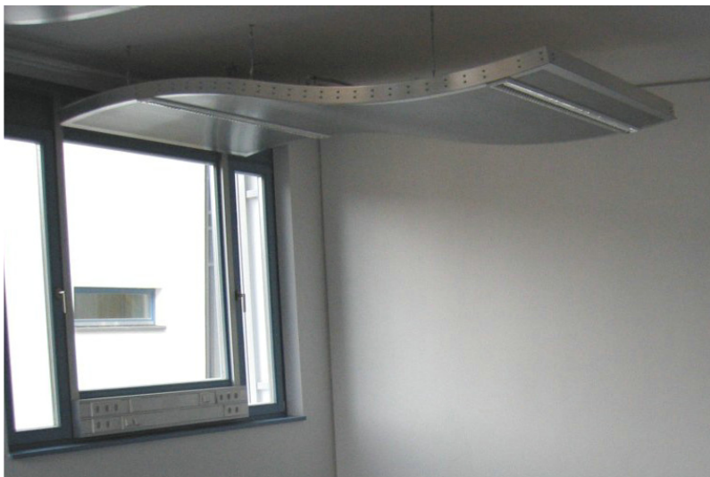
Bild 5.14: Deckensegel mit integrierten Beleuchtungseinrichtungen
