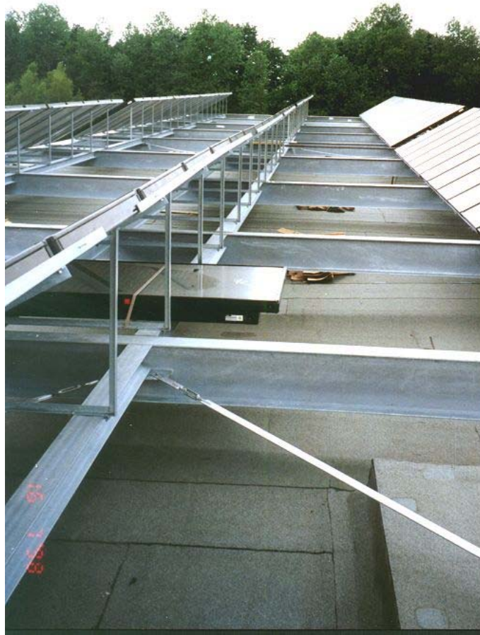
Abbildung: Detailansichten zum Kollektorfeld einschließlich Aufständering / Tragwerk
