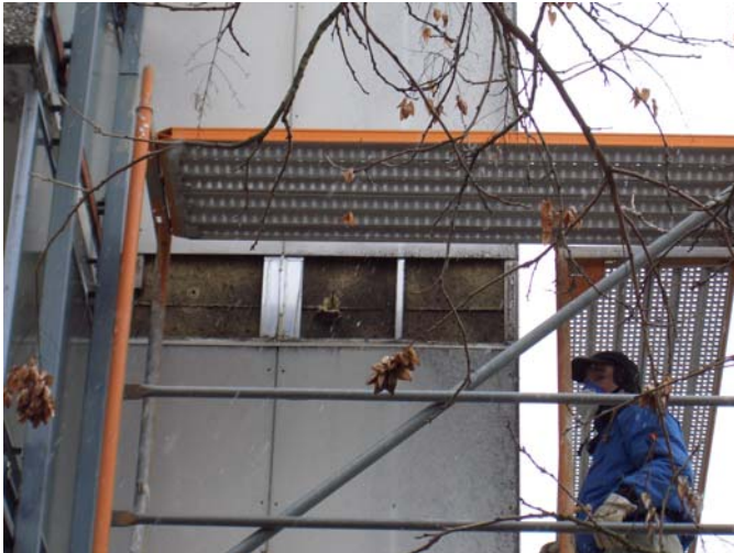
Abb.8-19 Fassadensanierung, alte Asbestzement- und Mineralfaserplatten
