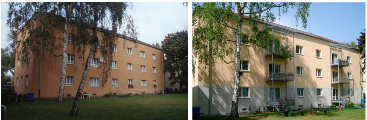
Abb. 8-1: Das Gebäude vor und nach der Durchführung der Maßnahmen
