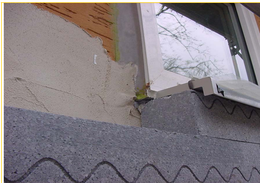
Abb.8-4 Wärmedämmverbundsystem auf Polystyrolbasis
