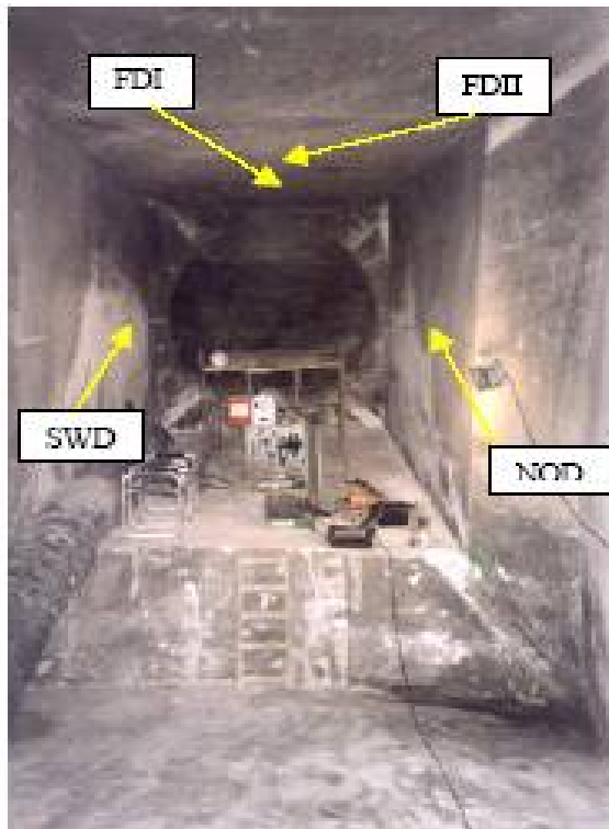
Bild 13.2: Blick in den vorbereiteten Streckenbereich zum Einbau von Dichtelement und Widerlager, FDI und FDII zeigen zwei Messpunkte in der Firste des Dichtelements (FD), SW und NO zeigen die Ausrichtung an (Südwest und Nordost), aus Häfner (2001)
