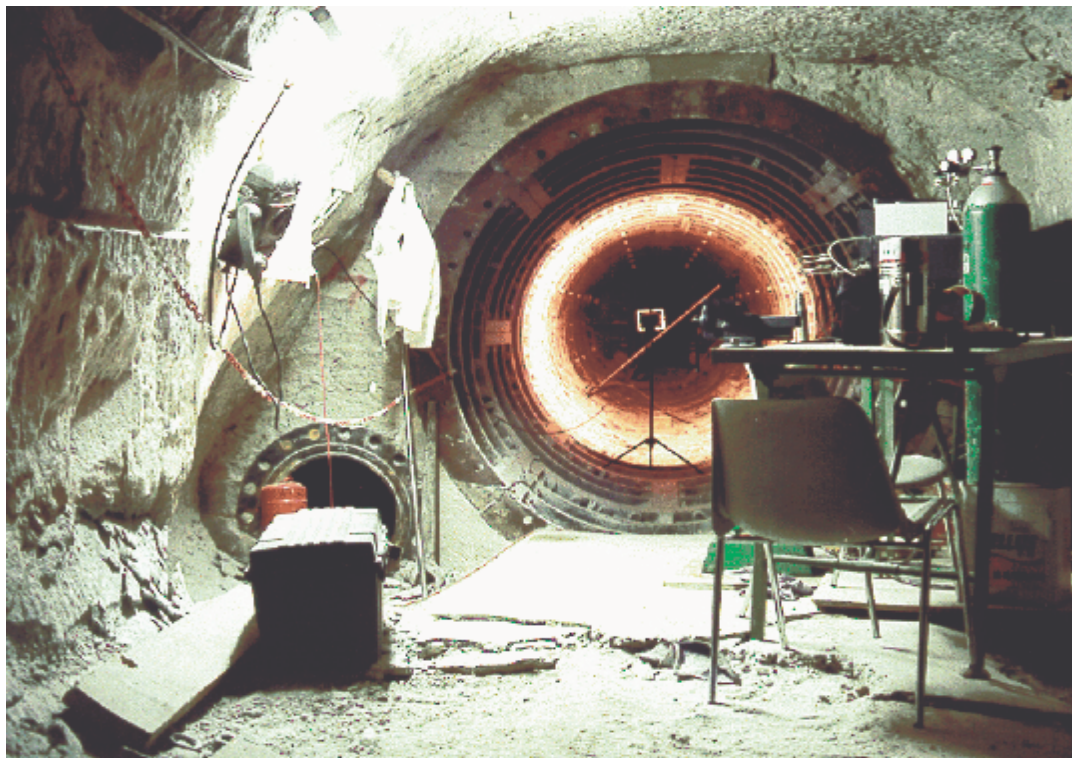
Bild 12.2: Blick in die ausgebaute Strecke
