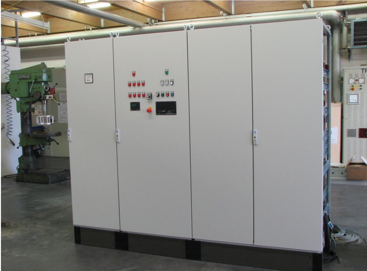
**Bild 15, Schaltschrank des supraleitenden Schwungradspeichers**
