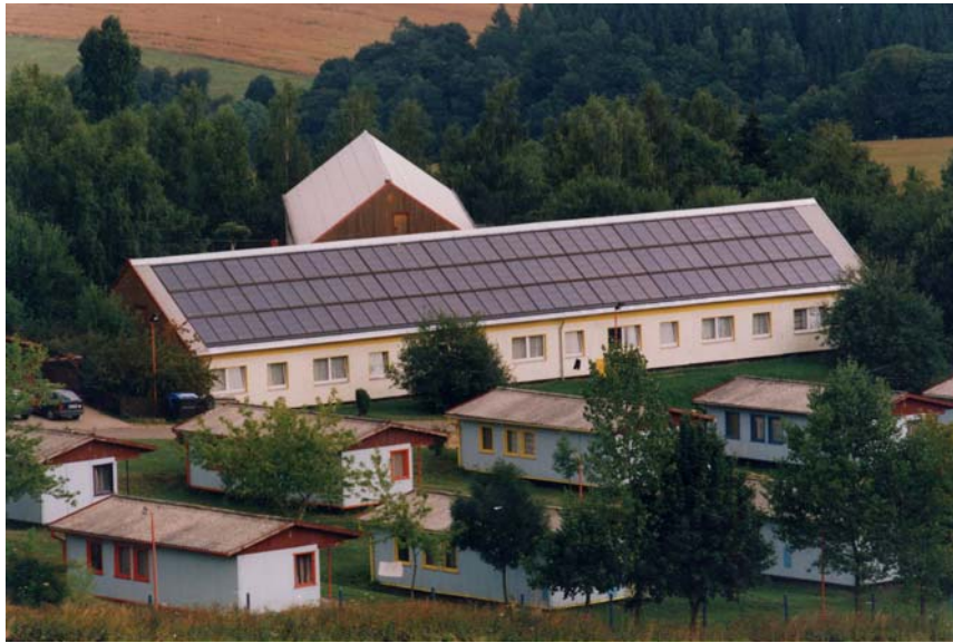
Abb. Gesamtansicht des Kollektorfeldes auf dem Dach des Bettenhauses 1, aus südwestlicher Richtung (Foto: KIEZ Güntersberge)
