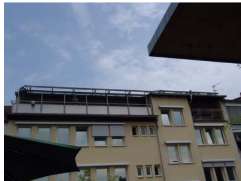
Abb. 24 Ansicht des Bürogebäudes (Quelle: Foto J. Bühl Ilmenau 2006)
