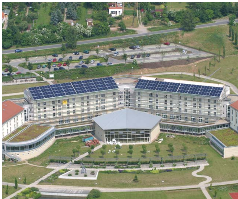
Abb. 19 Ansicht der Kollektorfelder (Quelle: Bild Xtoday-Media Verlag 2003)
