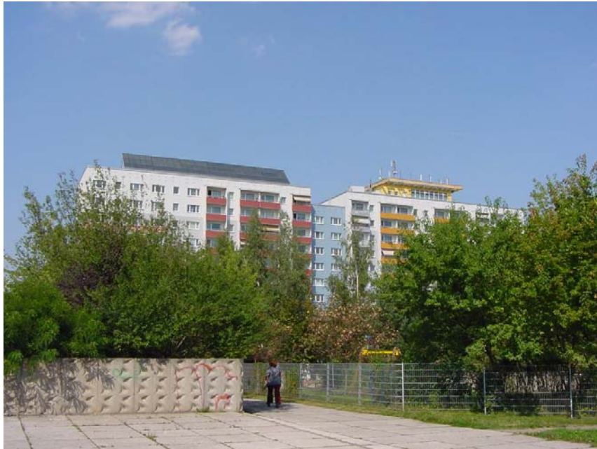
Abb. Ansicht des Kollektorfeldes auf dem Dach des Wohngebäudes Warschauer Str. 26 (Foto: J. Bühl Ilmenau 2002)
