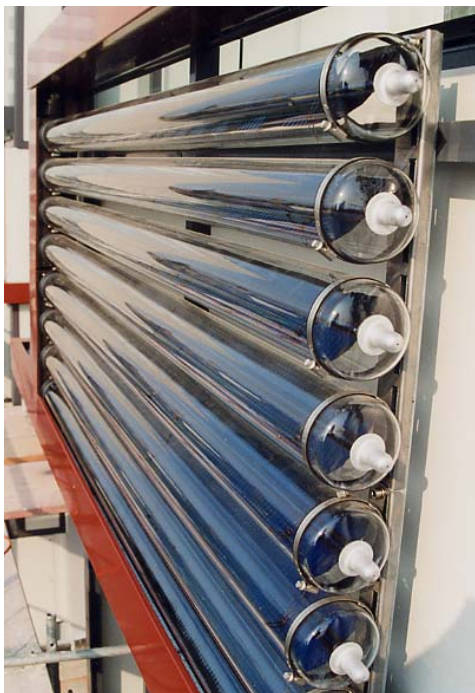
Abb. Teilansicht des Kollektorfeldes Gagarin-Ring 128 (In den roten Verkleidungen ist die Verrohrung der Kollektoren untergebracht. Die Sammelleitungen der Stränge sind unter der Fassadenisolation nach oben in den Drempeel geführt.) (Foto: TU I FG TFD 2001)
