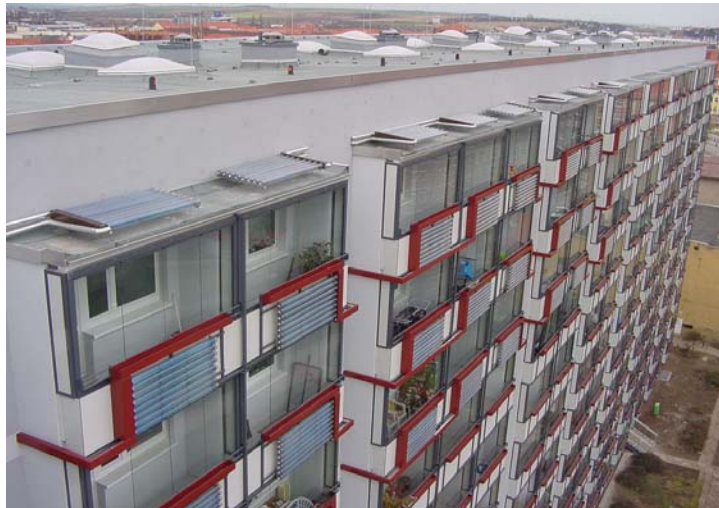
Abb. Teilansicht des Kollektorfeldes Gagarin-Ring 128 (In den roten Verkleidungen ist die Verrohrung der Kollektoren untergebracht. Die Sammelleitungen der Stränge sind unter der Fassadenisolation nach oben in den Drempeel geführt.) (Foto: TU I FG TFD 2001)
