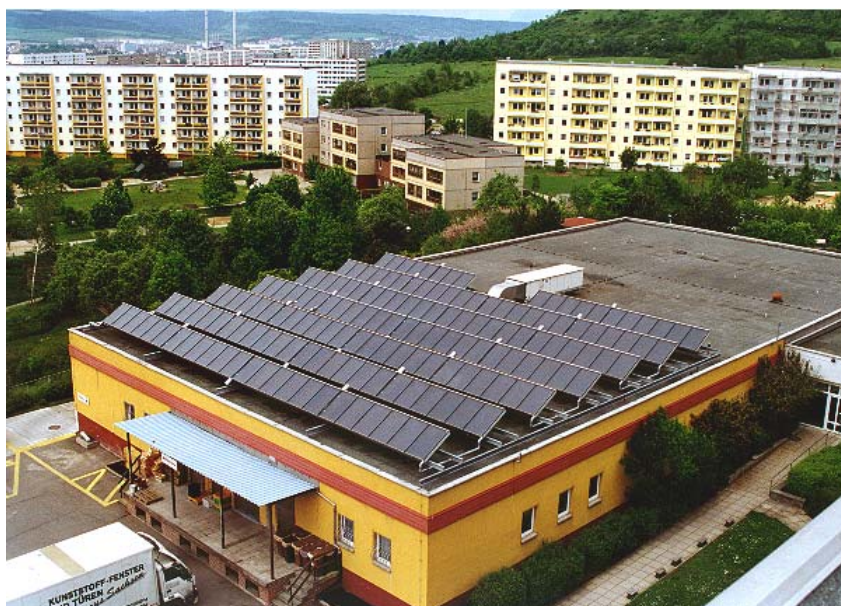
Abb. 06 Kollektorfeldansicht (Quelle: TU Ilmenau 1996)
