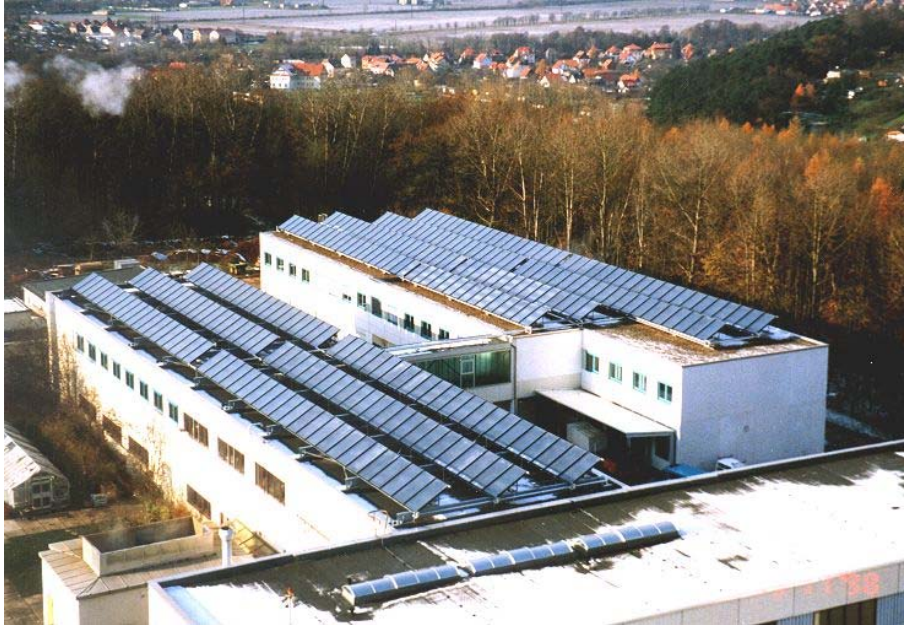
Abb. Gesamtansicht des Kollektorfeldes auf dem Dach der Technischen Versorgung und der Apotheke (Foto: TU I / FG TFD 01 mit freundlicher Genehmigung durch Ing.-Büro für Licht- und Solartechnik Sondershausen)
