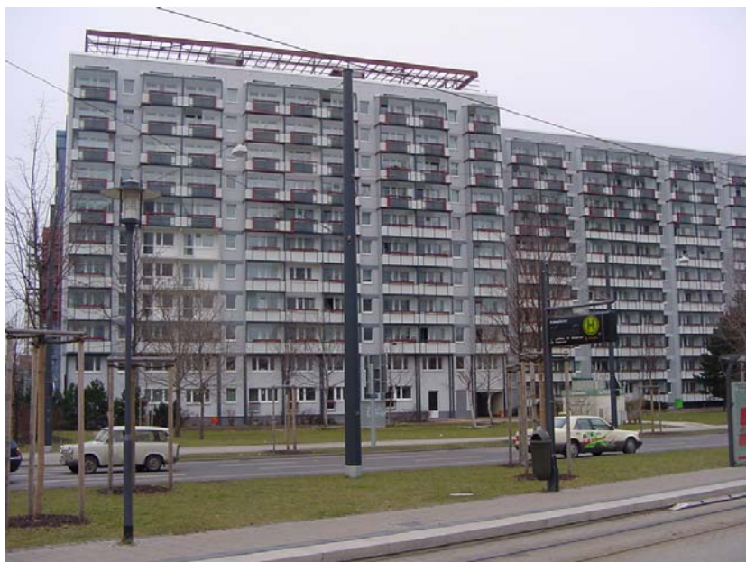
Abb. 14 Frontansicht des Röhrenkollektorfeldes (Quelle: Foto: TU Ilmenau 2001)
