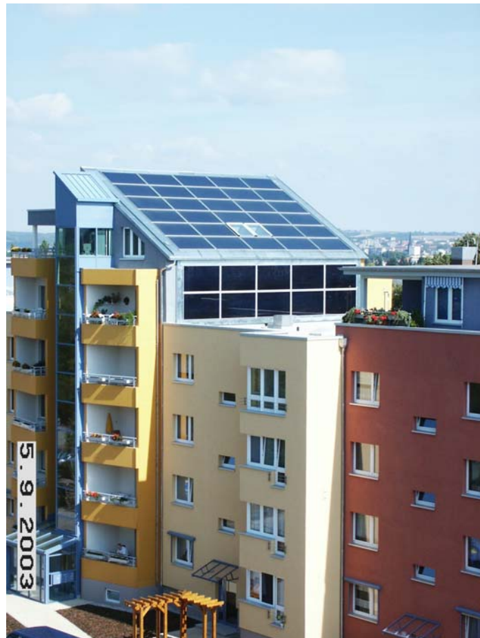
Abb. Kollektorfeld und Gebäudeansicht (nach dem Umbau) (Foto: Beutler Ingenieure 2003)
