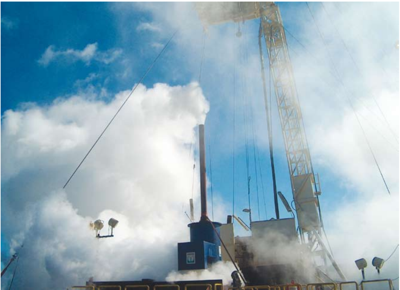
Abb. 19: Geothermiebohrung Unterhaching GT1
