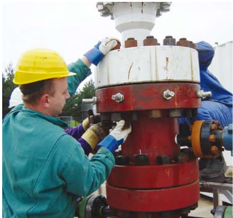
Abb. 9: Arbeiten am Bohrlochkopf
