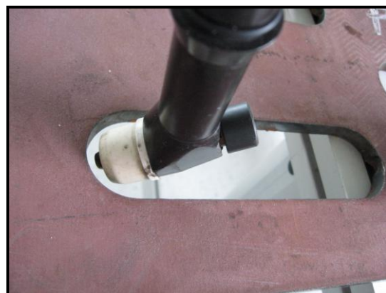
Bild 75: Brenner von oben an der Unterkante
