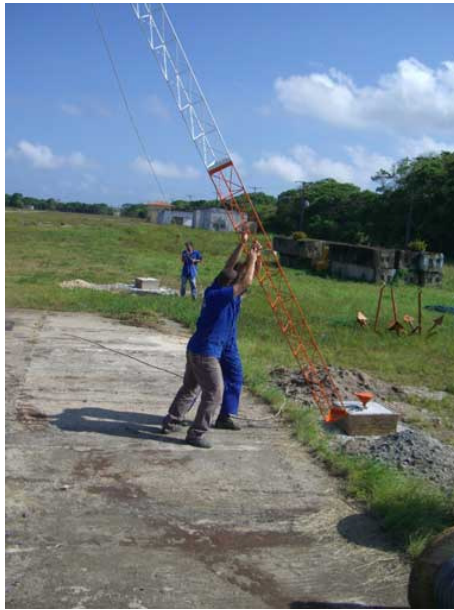
Abb. 13-14: Optimierung der Funkstrecke durch zusätzlichen Antennenmast
