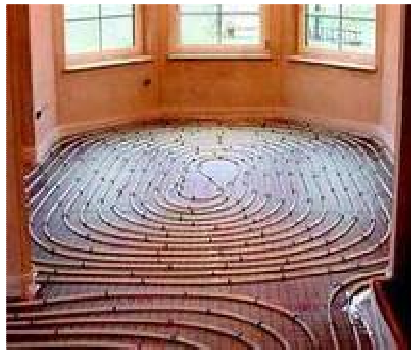
Abbildung 40: Fußbodenheizung beim Einbau (www.weidinger.at)
