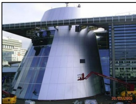
Abb. 2.C-05: montierte „Fassadenhaut“
