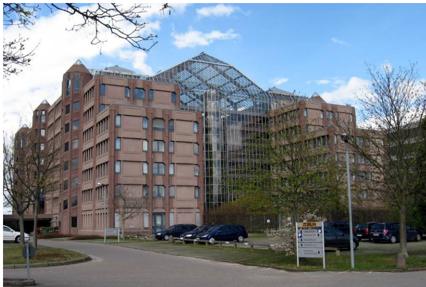
Bild 1. Züblin Hauptverwaltung Stuttgart
