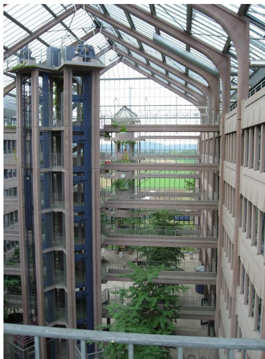
Abb. 2.A-08: Foto – Innenhof Westseite
