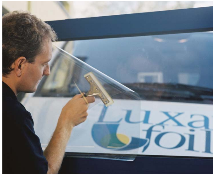
Abb.: 6.2.2- 2 Montage der Energiesparfolie ( Quelle: Luxasolar)
