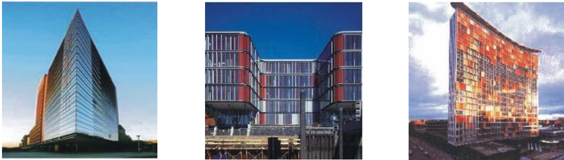
Bild 11. Drei von dreizehn Gebäuden aus dem Projekt TwinSkin mit Doppelfassaden.
