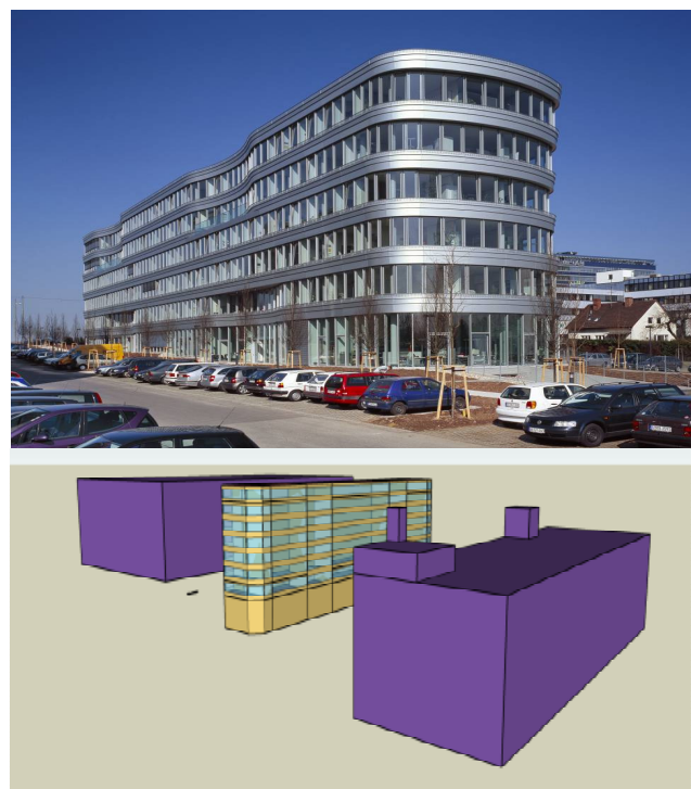
Abb. 5.2.2.4-17: „Z-zwo“ – in realiter und als „SketchUp“ - Modell mit externen Schattenspendern
