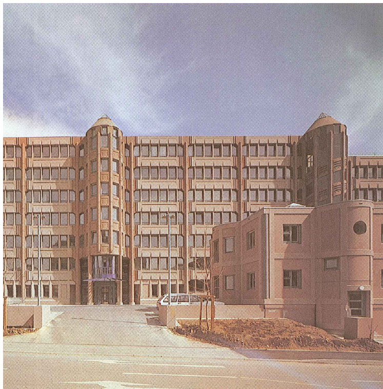
Westfassade mit Haupteingang und Wohnhaus 1
