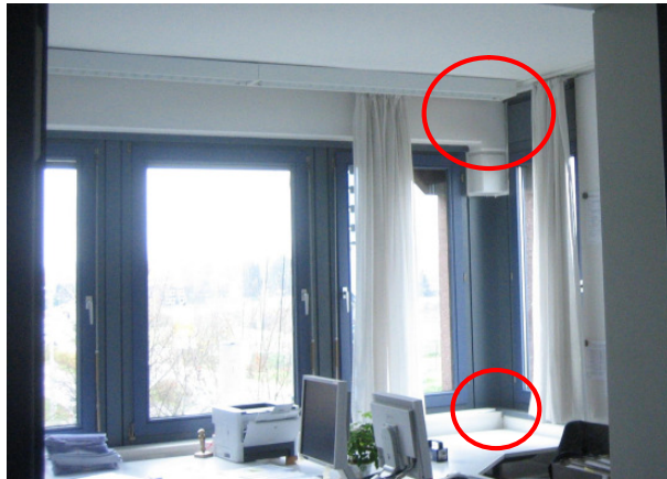
Bild 9: Büroraum B302 (Nord/West Ecke)
