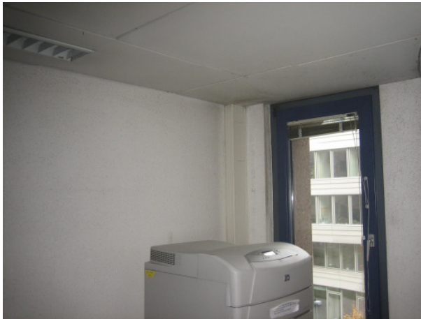
Bild 7: Kopierraum B 225 (Ostseite)
