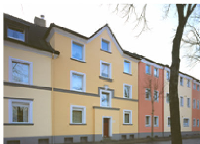
Abbildung 95: Einsatz verschmutzungs-unempfindlicher Siliconharz-Fassadenfarbe bei einem Gebäude in Duisburg (Caperol)
