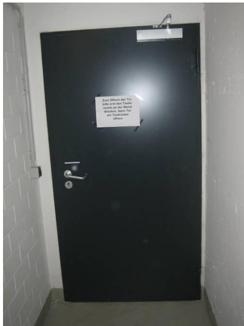
Bild 6: Türe zur Tiefgarage
