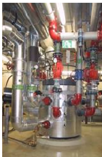
Abbildung 45: Installierter Verteiler
