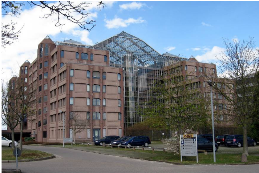
Bild 1. Züblin Hauptverwaltung Stuttgart
