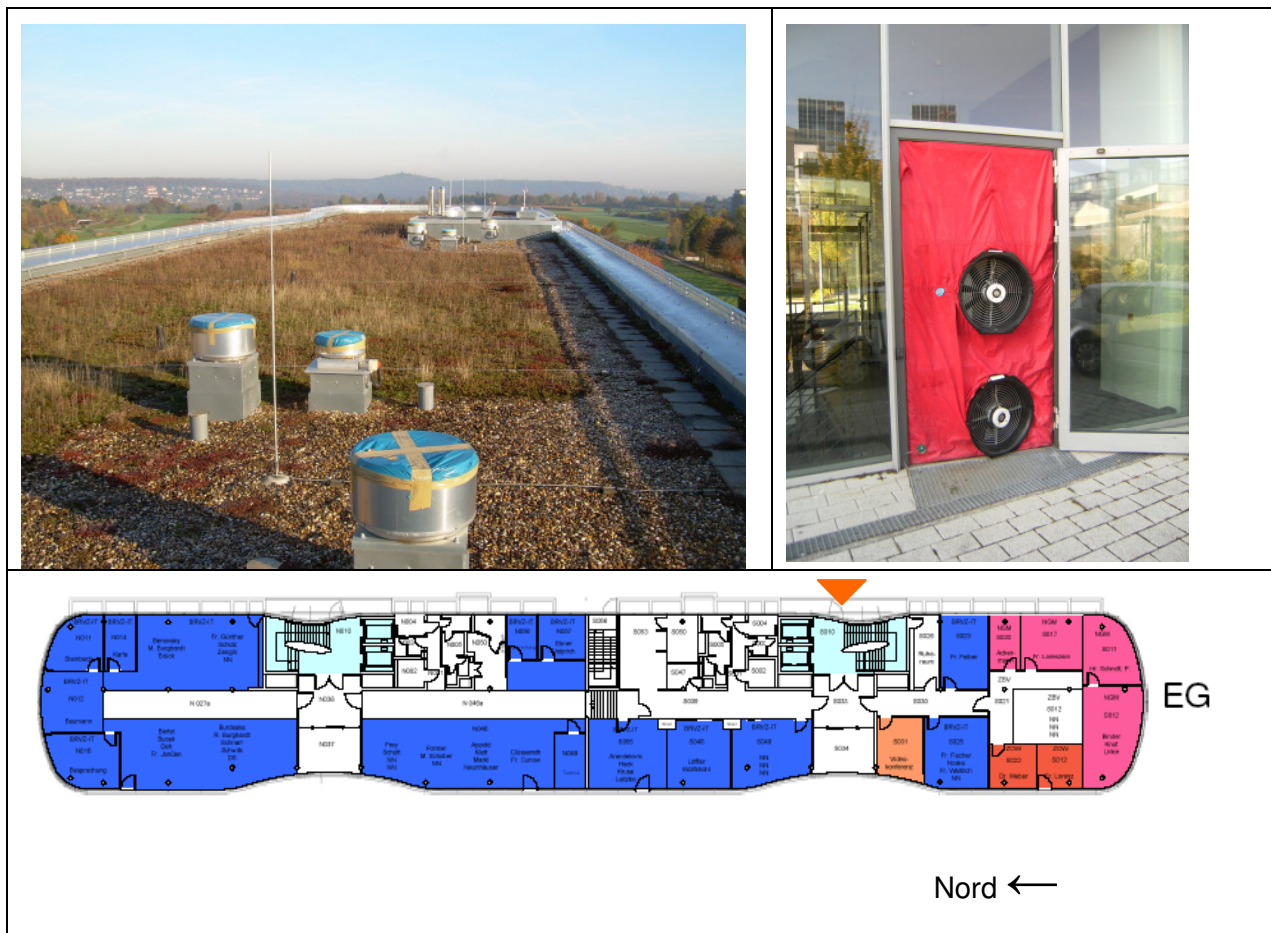
Abbildung 3.10.3.2.- 1: Präparation Dachebene sowie Einbauort der Ventilatoren im EG-Treppenhaus Süd
