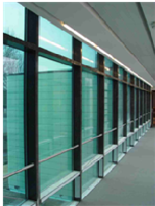
Abbildung 58: Schaltbares Isolierglas EControl® (www.glas-voit.de)
