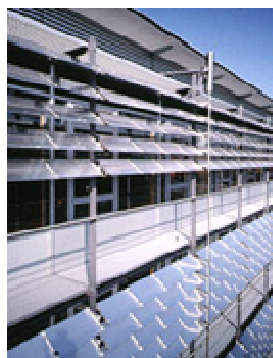
Abbildung 70: Bewegliches Prismensystem bei der Hauptverwaltung der Sparkasse Fürstenfeldbruck ( www.siteco.de )
