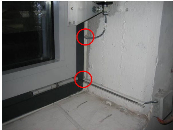
Bild 3: Oberlichter Südostseite (1. UG)
