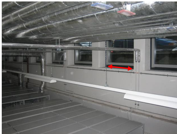
Bild 2: Oberlichter Südostseite (1. UG)
