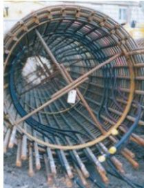
Abbildung 30: Energiepfahl (www.katzenbach- ingenieure.de)
