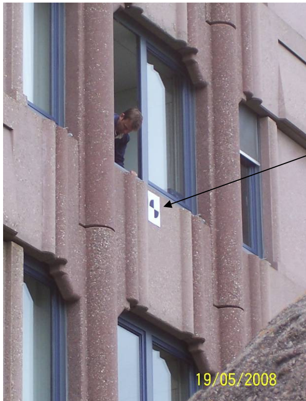
Abb. 5.3.2.2-01: Anbringen von Zielzeichen als Referenzpunkte auf der Außenfassade
