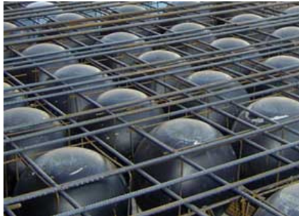
Abbildung 99: Betondecken aus Leichtbeton mittels Kugel-Hohlkörper ( www.ecodesign-beispiele.at )
