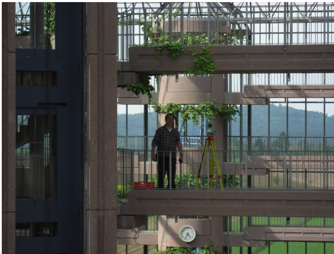
Abb. 2.A-09: Innenhof – Mittelbrücke: tachymetrische Einmessung des Referenznetzes
