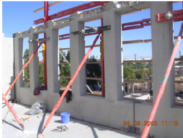
Abbildung 2: Montage der aussteifenden Lochfassade beim Telekom Center München (Foto Ed.Züblin AG)
