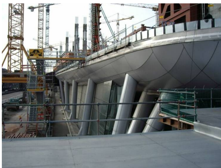
Abb. 2.C-13: Montage der mehrfach gekrümmten Fassaden-Elementen
