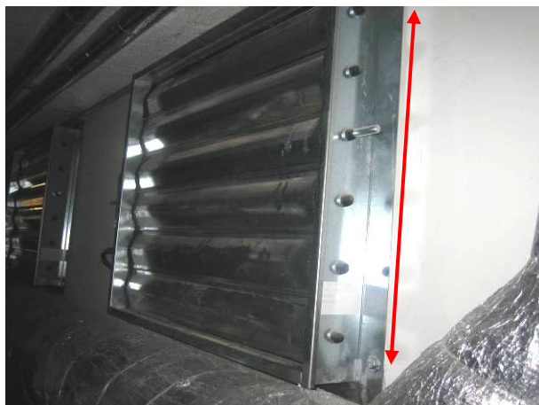
Bild 5: Entrauchungsklappen (2. UG)
