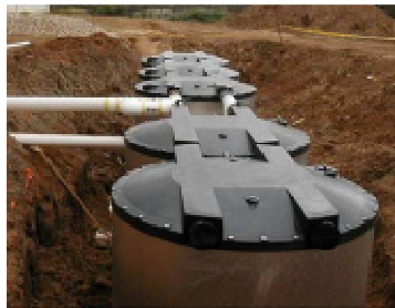
Abbildung 35: Eisspeicheraufstellung, vergraben (www.calmac.at)
