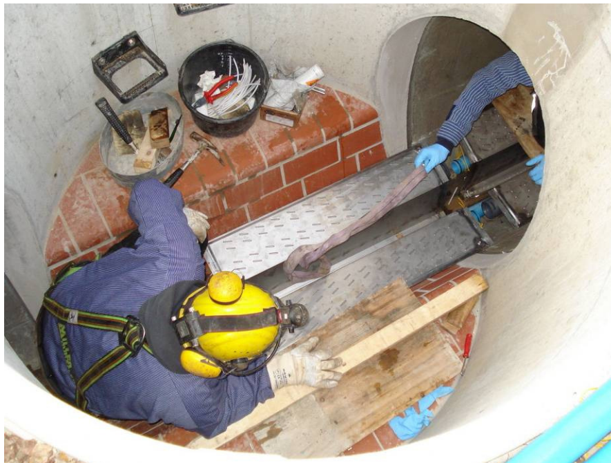
Abb. 6.3.4.- 5: Der Abwasserwärmetauscher kann nachträglich eingebaut werden (Quelle: URHIG)
