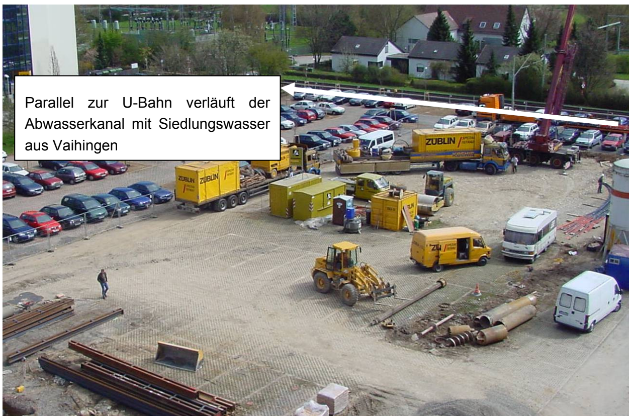
Abb. 6.3.4.- 3: Möglich Abwasserkanalwärmetauscherposition (Blick aus Züblin-Haus auf Baustelle Z-Zwo 2001)
