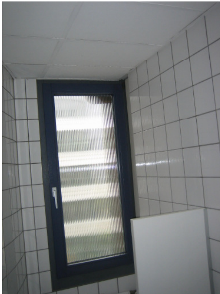
Bild 5: WC Bereich 251 (Ostseite)
