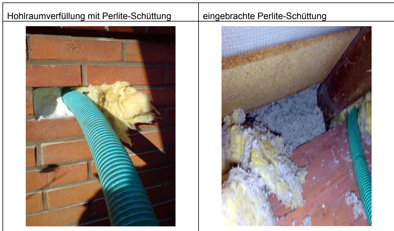
Abb.: 6.2.6- 1: Einbringen der Perlite-Schüttung mittels Schlauch (Quelle: Xella)
