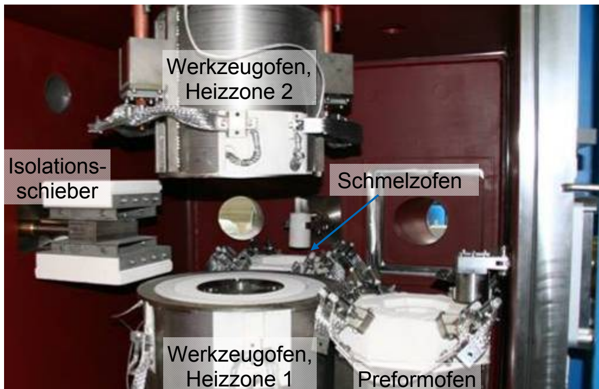
Abb. 96: Innenansicht HTSC-Anlage, Aufbau im Inneren des Vakuumbehälters
