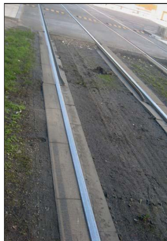
Abb. 20: Abscheren der Vegetation bis vollkommene Zerstörung durch Einfahrten ins Gleis
