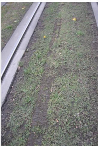
Abb. 20: Abscheren der Vegetation bis vollkommene Zerstörung durch Einfahrten ins Gleis
