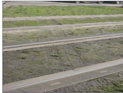
Abb. 20: Abscheren der Vegetation bis vollkommene Zerstörung durch Einfahrten ins Gleis
