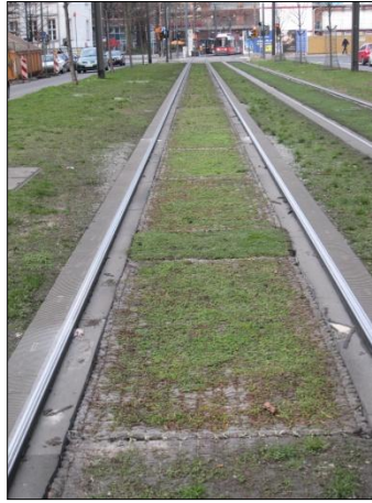
Abb. 19: Gleis nach Wiedereinbau 12/2008
