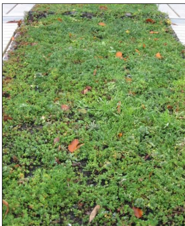
Abb. 4: vorkultivierte Gleisbettmatte nach Einbau ins Gleis
