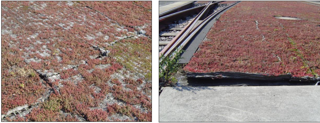
Abb. 16: zu geringe Deckung nach 2 Jahren Abb. 17: Krumpfung /Schüsselbildung der Matte Schrumpffugen
