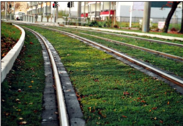
Abb. 5: Gleisbettbegrünung mit mobiler Gleisbettmatte in Chemnitz
