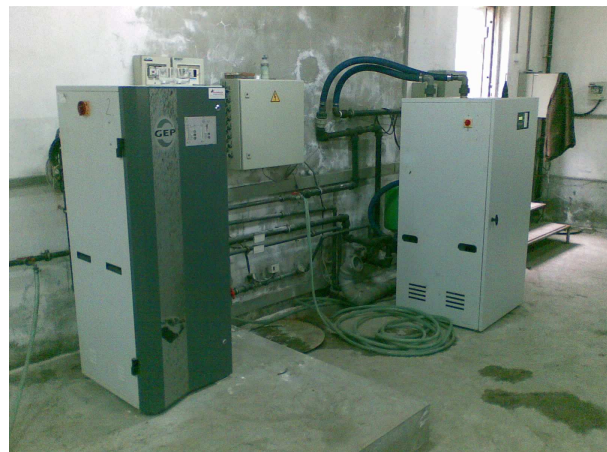
Abbildung 4 links: ursprüngliche Regenwasserzentrale (GEP Umwelttechnik GmbH, BMBF-Projekt Förderkennzeichen 01WA0047); rechts: neue Regenwasserzentrale nach Umbau.
