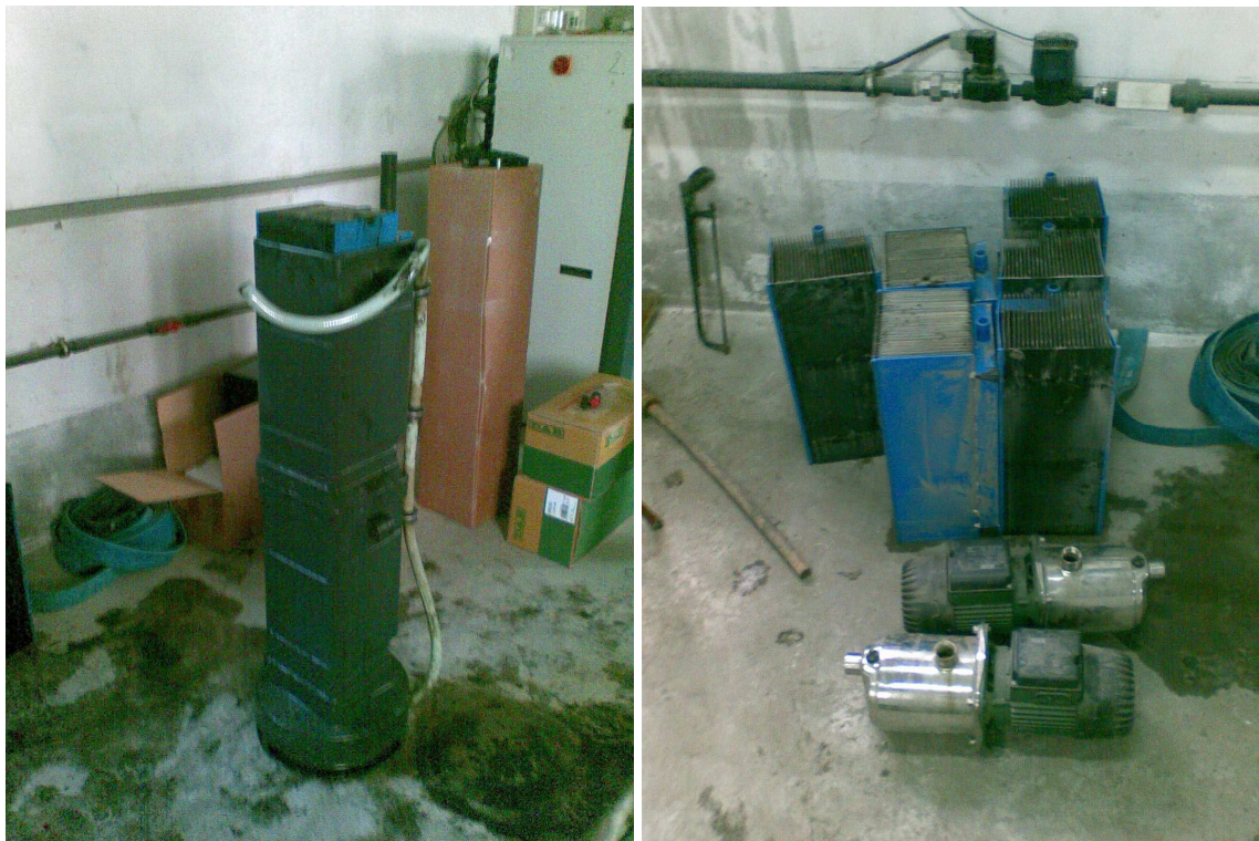
Abbildung 1 ausgebauter Doppelfilter (links) und getauschte Filtermodule und Druckpumpen der Druckerhöhungsanlage (rechts).
