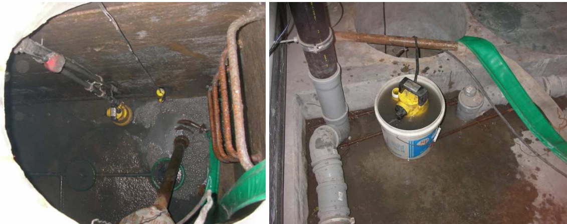
Abbildung 3 Hebepumpe am Boden des Belegungsbeckens (links) Funktionstest der Hebepumpe nach Ausbau (rechts).
