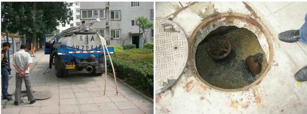
Abbildung 2 Tankwagen zum entleeren und Spülen des Septic tanks (links)
