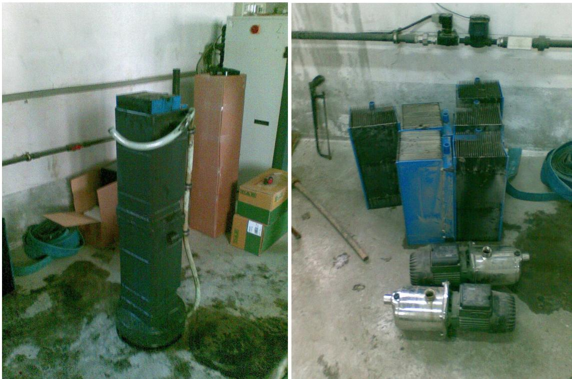
Abbildung 1 ausgebaute Doppelfilter (links) und getauschte Filtermodule und Druckpumpen der Druckerhöhungsanlage (rechts).
