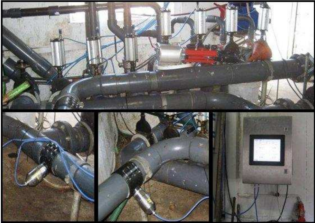
Abbildung 17: Einbindung der Messköpfe I und II (unten links) in den Verteilerbalken (oben) und die zentrale Auswerteinheit (unten rechts), Biogasanlage Bauer, Neuburg/Donau [eigene Darstellung]
