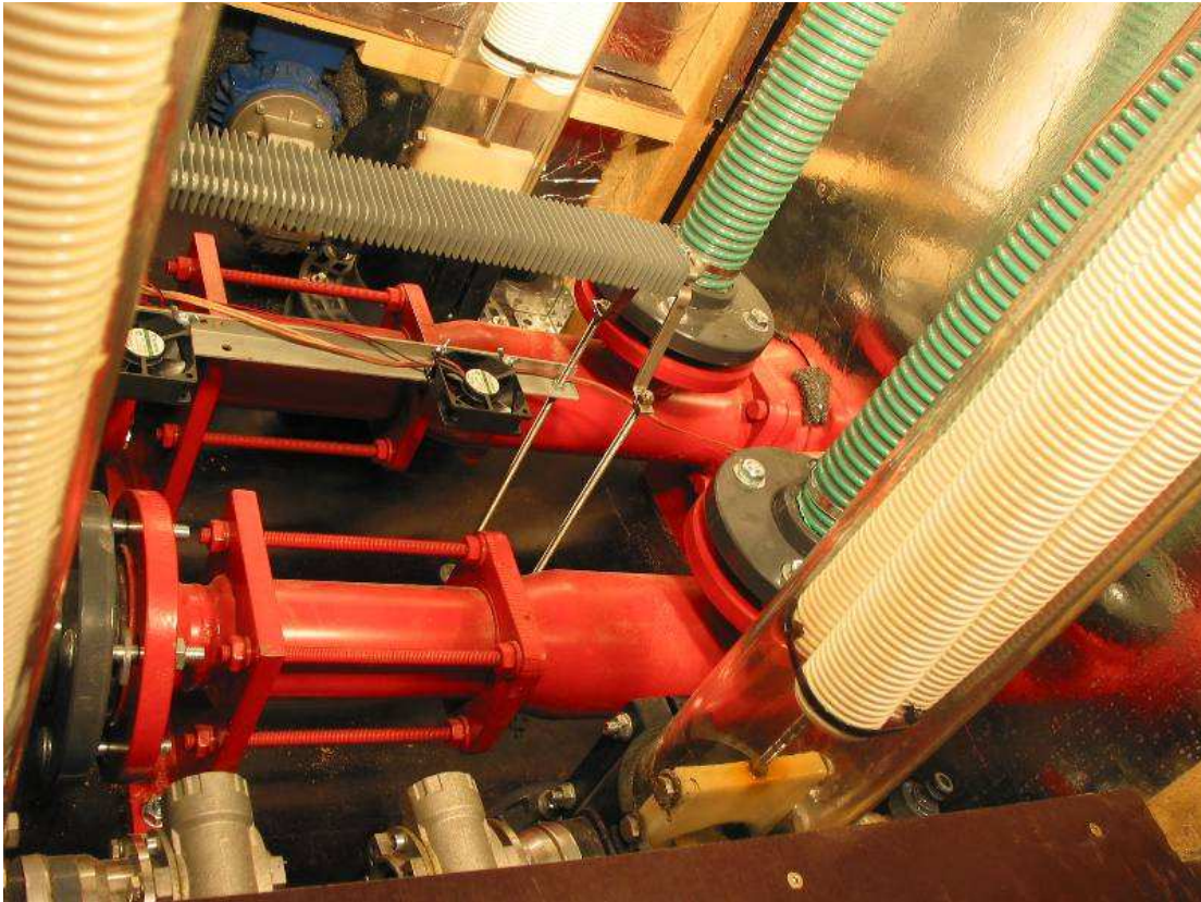
Abbildung 57: Exzentrerschneckenpumpe für den Reflow (eigene Darstellung)
