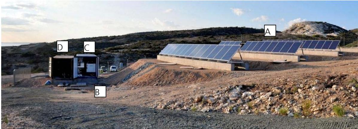
**Abbildung 27: PV-Generatoren beider Systeme (A), Rohranschlüsse zum Meer (B) sowie RO-Anlagen seaside (C) und maritime (D), Blickrichtung: Westen**
