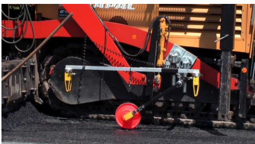
Abb. 27: Realisierte Schichtdickenmessung für den Binder
