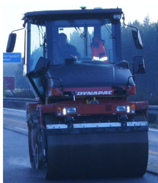
Abb. 45: Referenzstation und Walze im Einsatz
