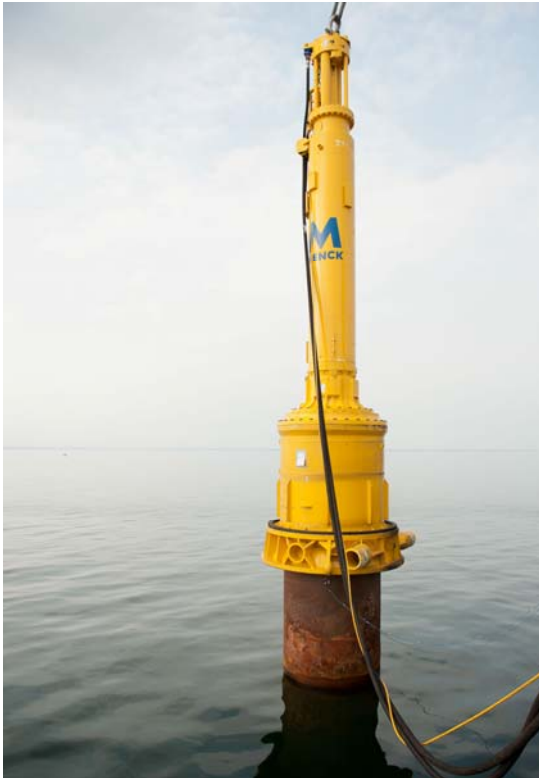
Abbildung 7: Auf den Pfahl aufgesetzter Hammer (Foto: Patrice Kunte)
