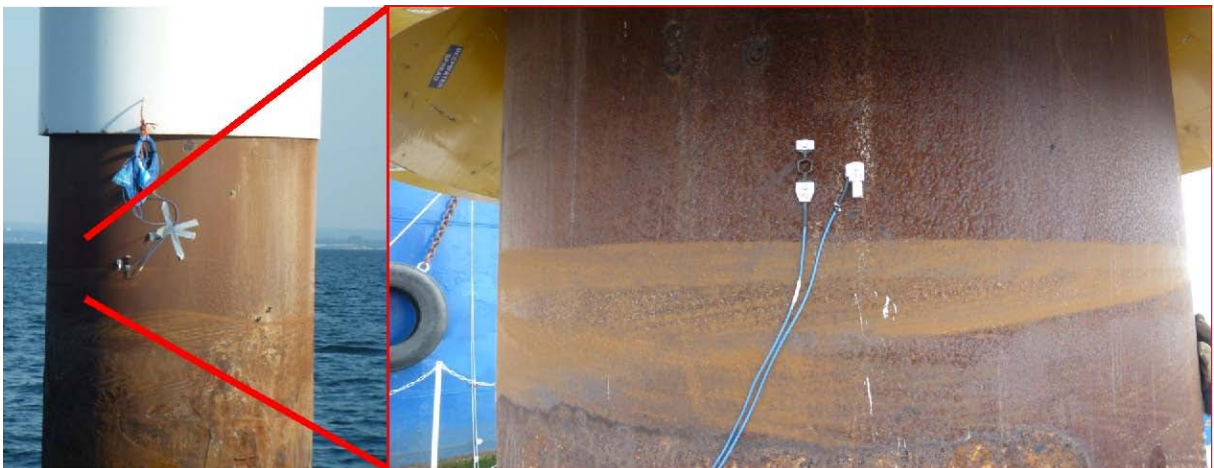
Abbildung 37: Messposition von Beschleunigungs- (rechts) und Dehnungssensor (links) am Brodtener Pfahl
