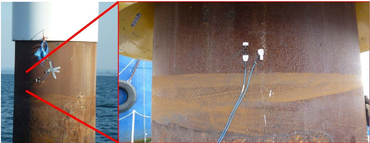
Abbildung 1: Messposition von Beschleunigungs- (rechts) und Dehnungssensor (links) am Brodtener Pfahl
