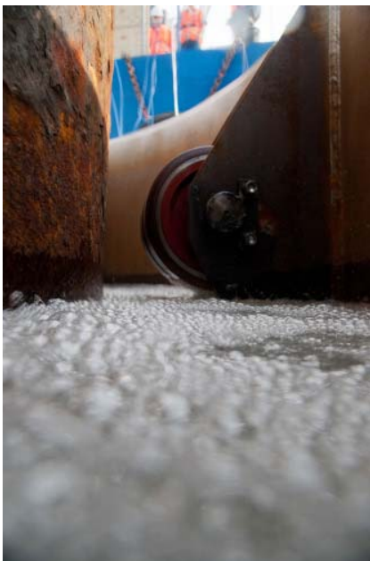
Abbildung 13: Blick in den Zwischenraum Pfahl/NMS während des Betriebs des Blasen-schleiers (Foto: Patrice Kunte)
