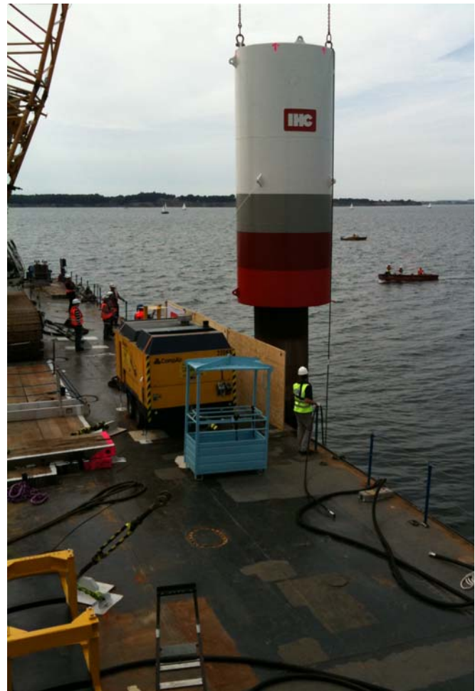
Abbildung 12: IHC NMS bei der Installation (Foto: Patrice Kunte)
