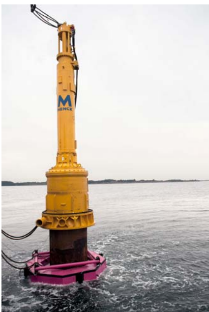
Abbildung 20: Kleiner gestufter Blasenschleier-LBC der Fa. Weyres im Einsatz (Foto: Patrice Kunte)
