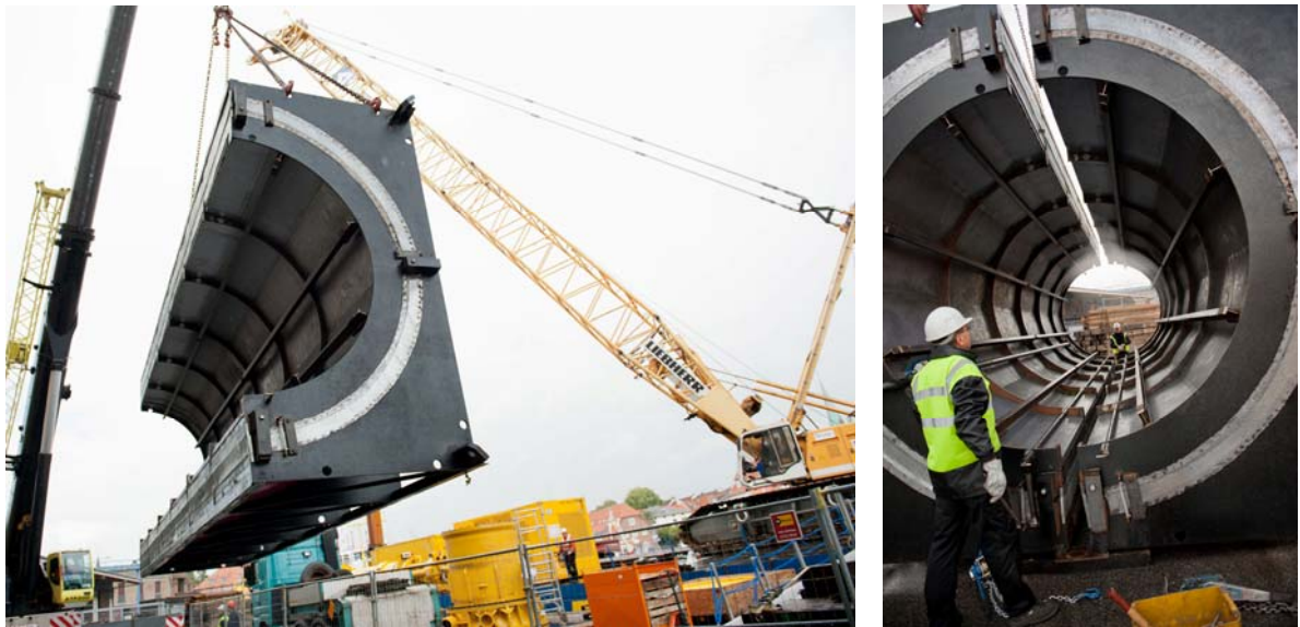
Abbildung 22: Zweiteiliger Aufbau der BeKa-Schale Fa. Weyres (Foto: Patrice Kunte)
