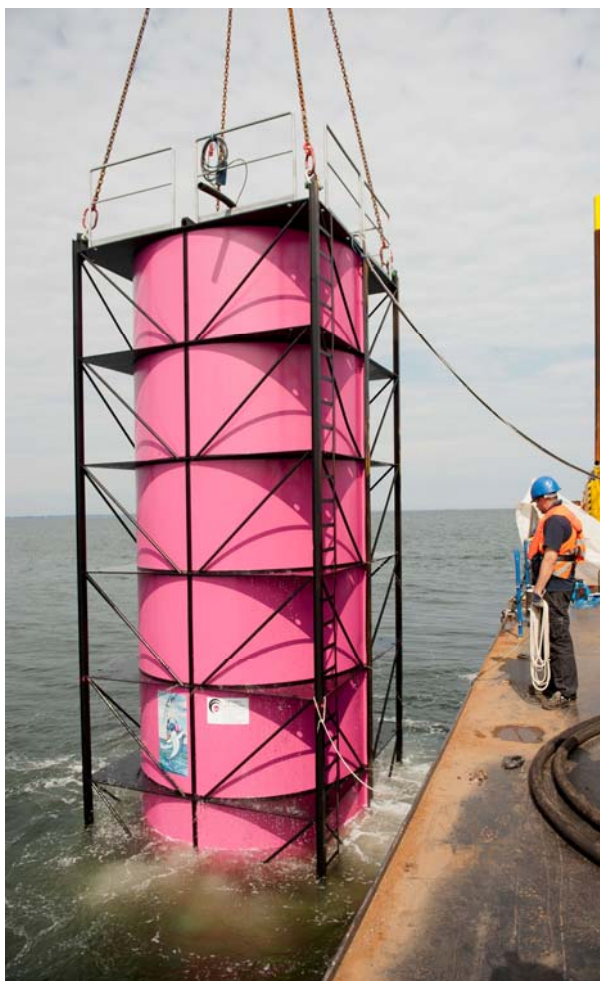
Abbildung 23: BeKa-Schale bei der Installation (Foto: Patrice Kunte)
