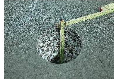
Abbildung 7: Bohrkern zur Messung der Schichtdicke
