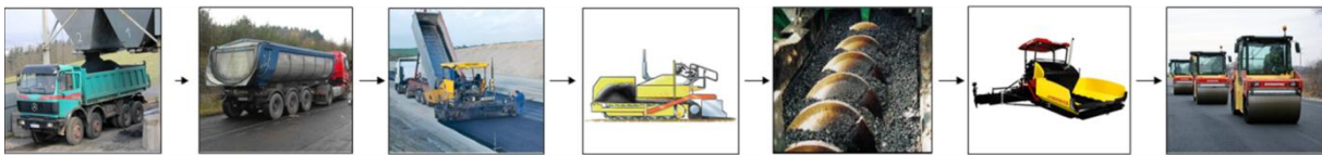
Abbildung 1: Einbauprozess beim Asphaltstraßenbau
