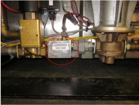
*Bild A-7: Temperatursensor zur Erfassung der Wassertemperatur*
