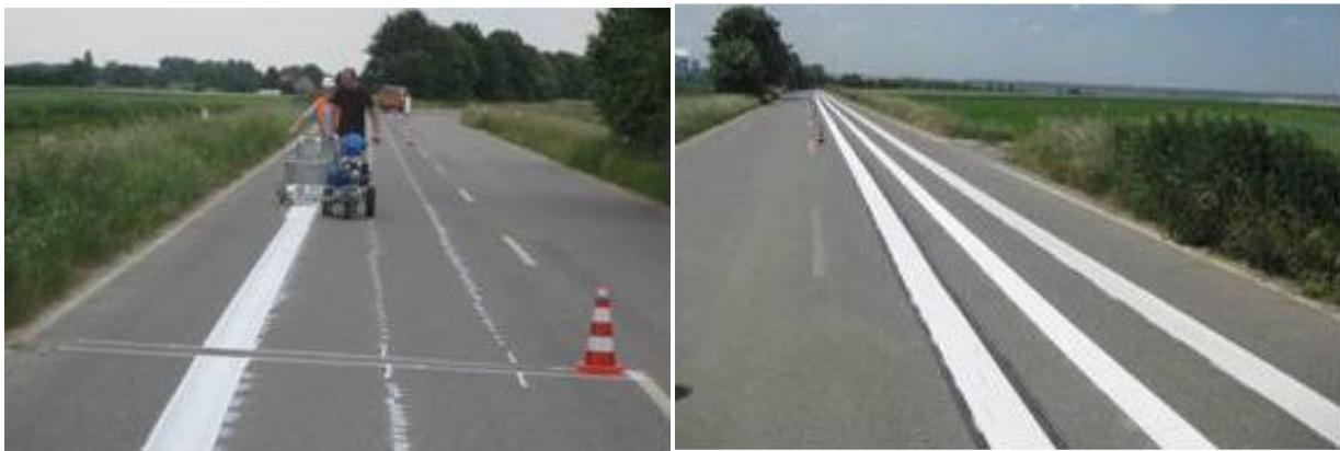
Bild A-18: Applikation der Farbmarkierung (links) und fertiges Versuchsfeld in Pier (rechts) (Schacht et al., 2012)
