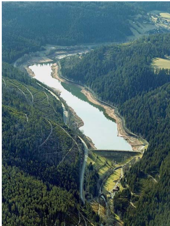
Abb. 2.2: Nagoldtalsperre mit Sperrenstelle im Vordergrund
