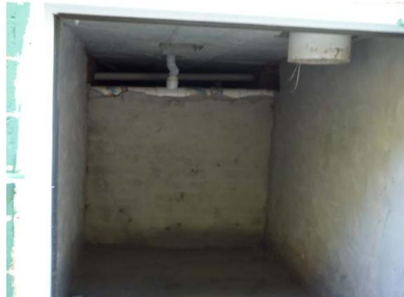
Abb. 39: Eine der 5 Trockenkammern unterhalb der Toiletten mit Lüftungsrohr (vorderes Rohr)
