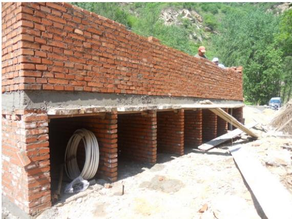
Abb. 27: Rückansicht des Rohbaus mit Einsicht auf die Trockenkammern
