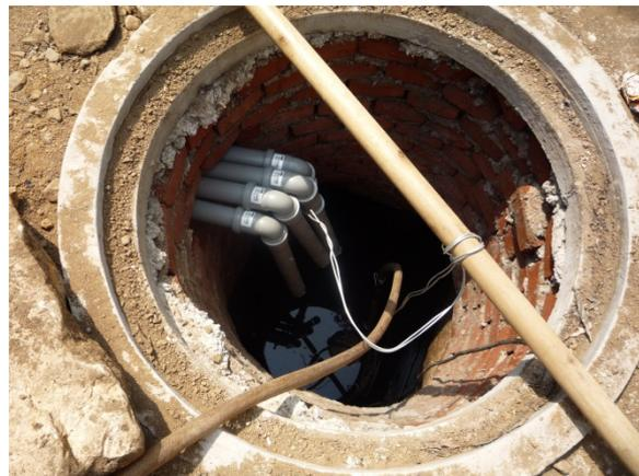
Abb. 18: Nach Fertigstellung der neuen Einmündung der Pumpenleitungen
