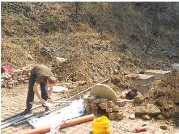
Abb. 17: Maße nehmen und zurecht schneiden der PVC-Rohre
