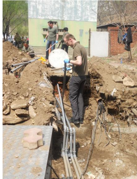
Abb. 16: Verlegung der neuen Pumpenleitungen zur Korrektur der Anbindungshöhe in die VK
