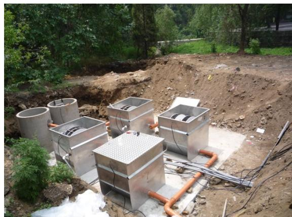
Abb. 12: Nach Montage der Verbindungs- und Pumpenleitungen
