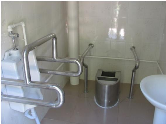
Abb. 38: Toilettenraum für Behinderte mit Urinal und selbstkonstruierter Sitztoilette aus Edelstahl
