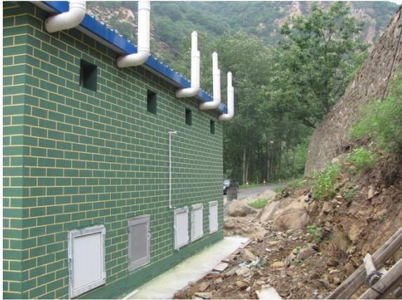
Abb. 31: Rückansicht mit Blick auf die Trockenkammertüren und Lüftungsrohre
