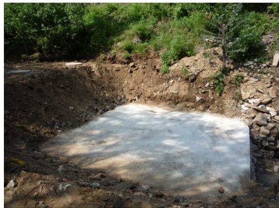
Abb. 10: Grundplatte für die Installation der RTK - Anlage
