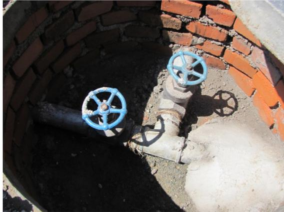
Abb. 40: Armatur für die manuelle Regelung zur Beschickung eines der zwei Urintanks
