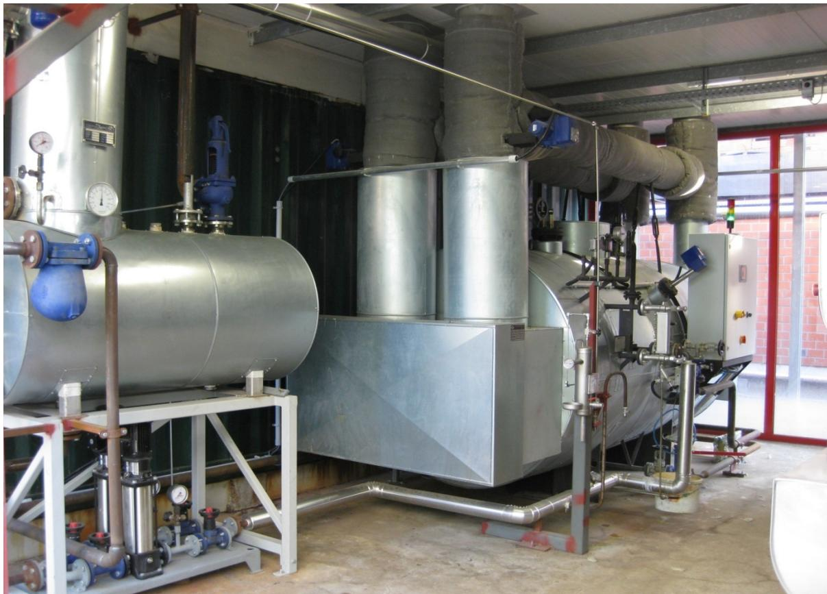
Abb. 8-6: Abhitzedampferzeuger einer dezentralen Brennerei
