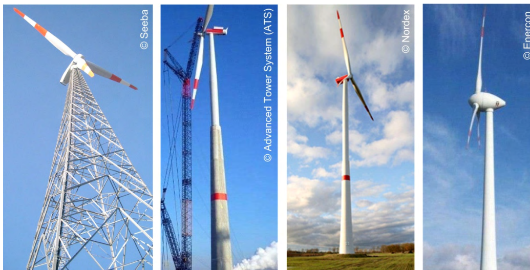
Abbildung I-3 links: Gitterturm; Mitte: Hybridvarianten; rechts: Fertigteilvervariante
