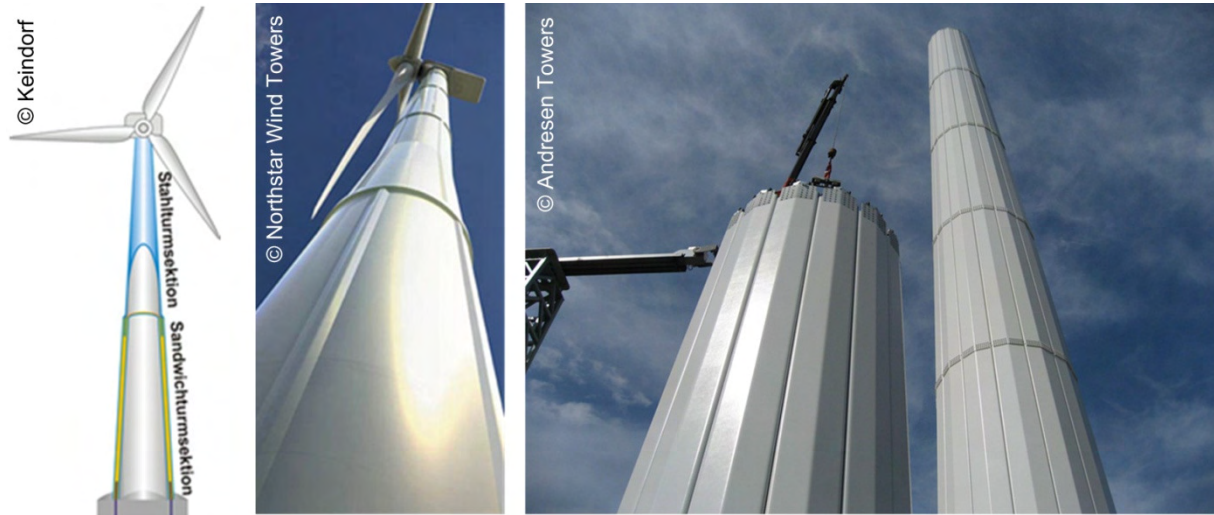
Abbildung I-4 links: Konzeptstudie: Sandwichtower (Keindorf, 2010); Mitte und rechts: Prototypen modulartig aufgebauter Turmschalen mit geschraubten Verbindungen
