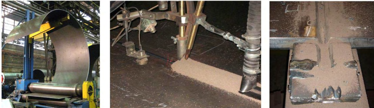
Abbildung I-6 Herstellung von Stahlrohrtürmen mit Mehrdraht-UP-Schweißtechnik im Werk SIAG Tube & Tower, Leipzig; links: Walz-Biege-Vorgang zum Formen der Grobbleche; Mitte: UP-Schweißvorgang; rechts: Ein- und Auslaufblech für den UP-Prozess
