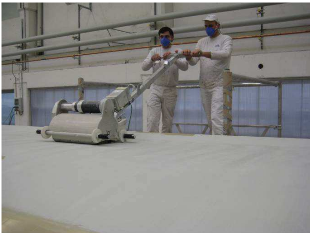
Abb. 5.1.3: Einsatz eines Flächenschleifers in der Bearbeitung der Rotorblattoberfläche
