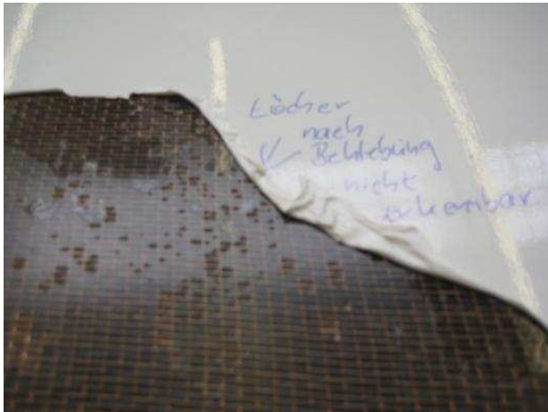
Abb. 5.1.2: Klebefolie direkt auf der Blattoberfläche aufgebracht
