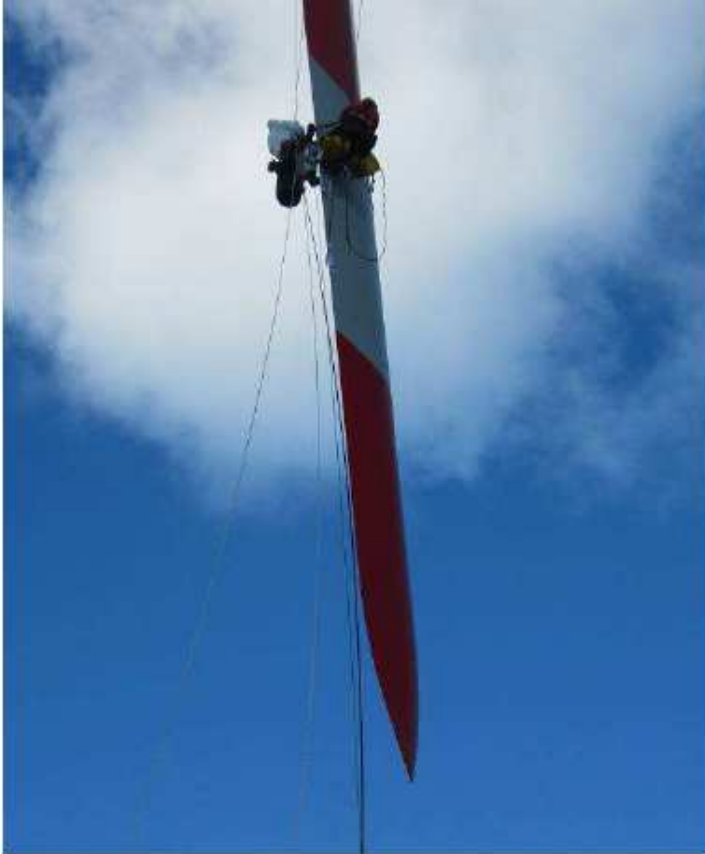
Abb. 5.2.4: Erste Kontrolle der im Offshore-Einsatz befindlichen Rotorblätter im Alpha-Ventus- Park
