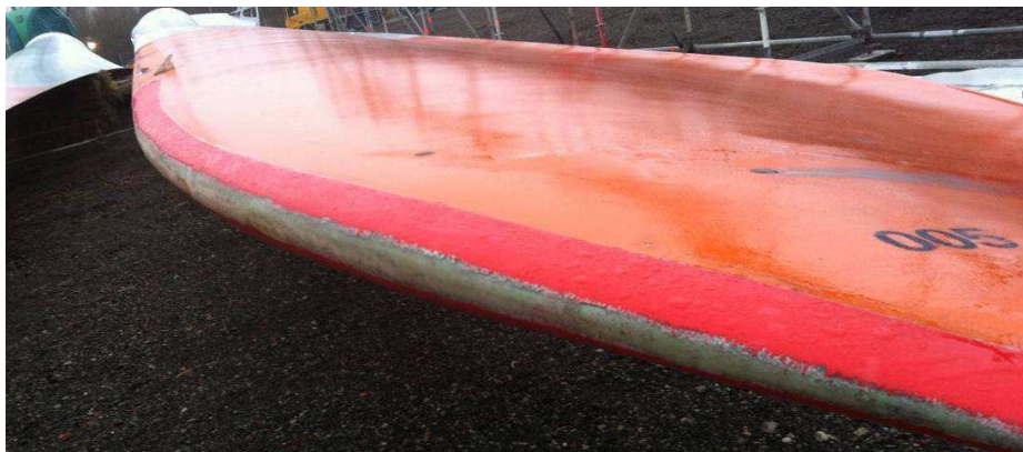
Abb. 5.2.3: Erosionserscheinungen an der Nasenkante von Onshore-Rotorblättern ohne Schutzfolie
