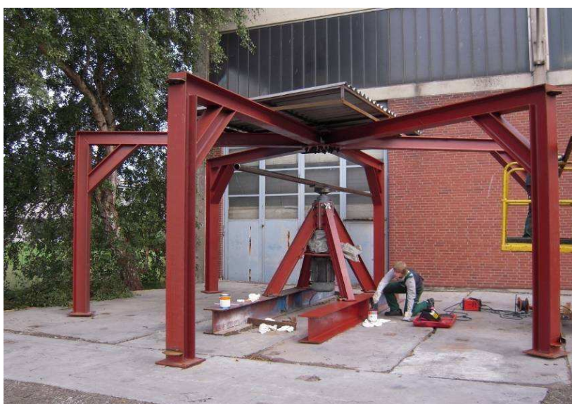
Abb. 5.2.14: Bau des neuen Erosionsteststandes
