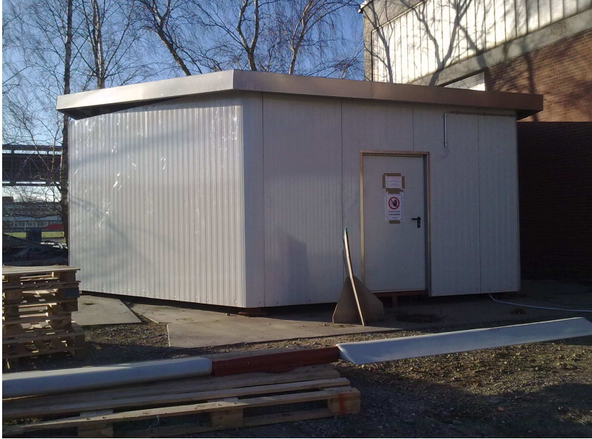
Abb. 5.2.15: Fertiggestellter Erosionsteststand von außen
