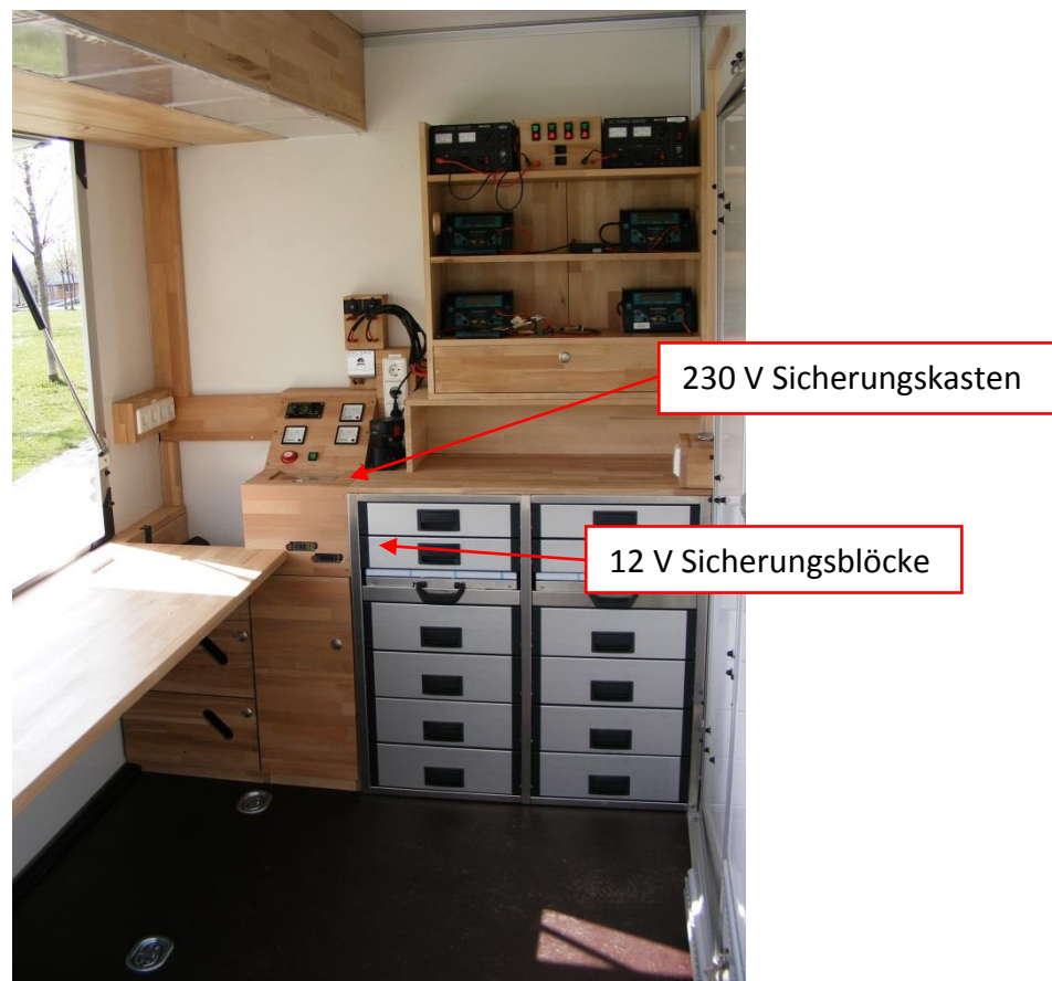
Abb. 65 Position der Sicherungsblöcke (12 V) und des Sicherungskastens (230 V)
