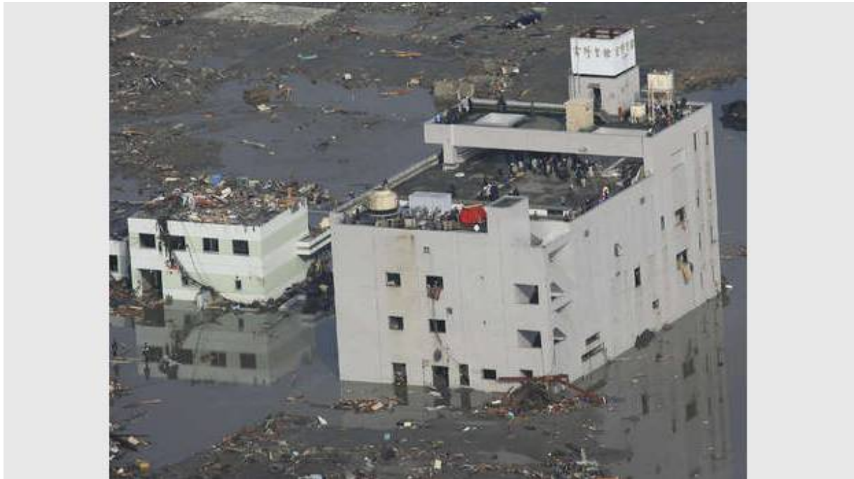
Abb. 10: Fukushima-Region. Menschen retten sich auf die Dächer der noch stabilen Häuser. 41
