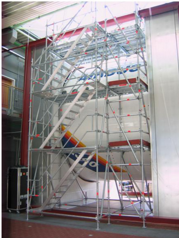
Eingerüstete Tonne
