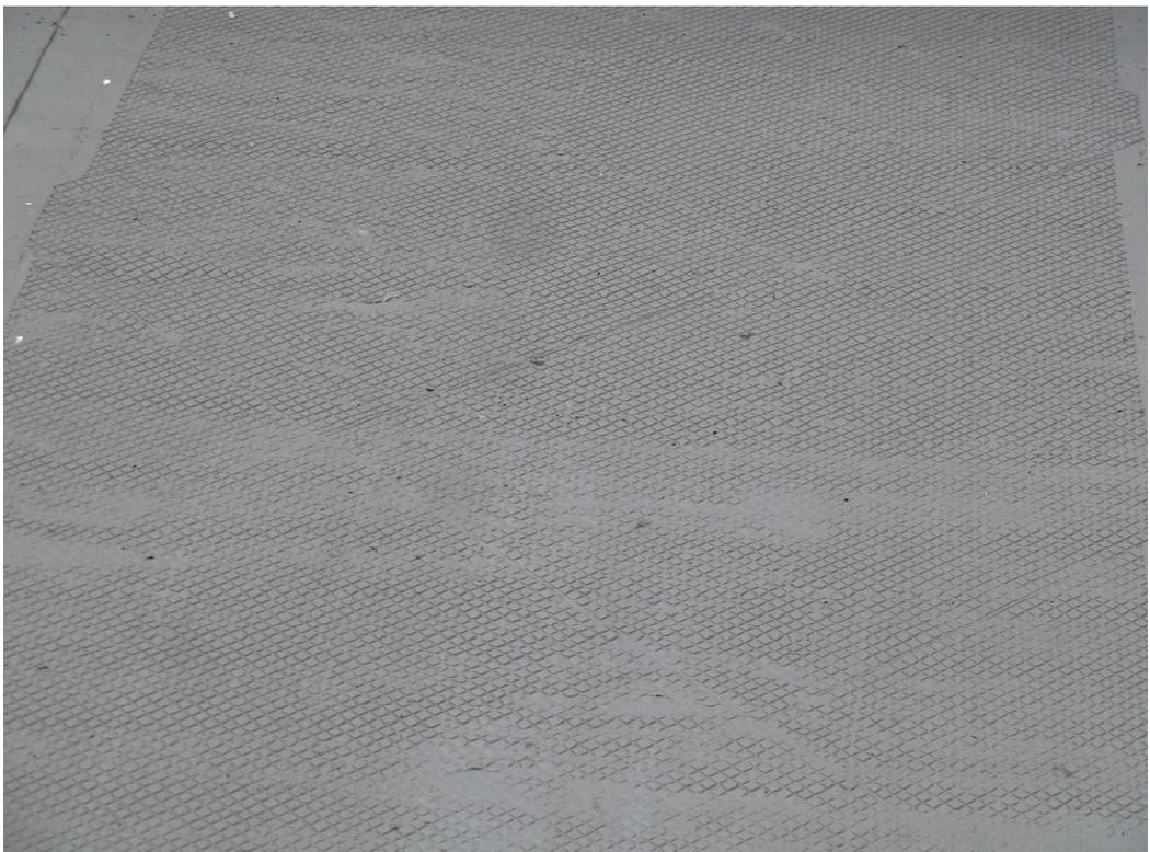
Bild D26: ... aber eine Prägung ist erst nach 90 min möglich (Abschnitt II).
