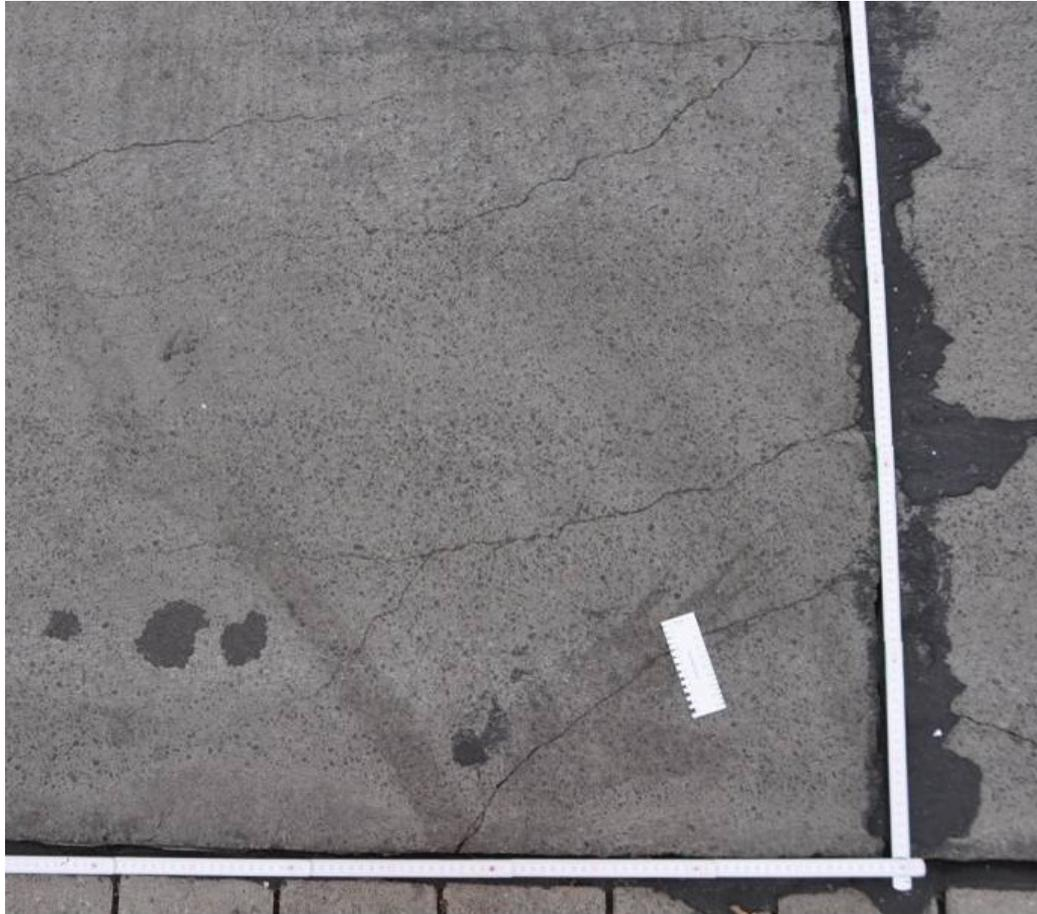
Bild D32: Längsrisse ausgehend vom Querriss (nachgearbeitet und mit Bitumen verfüllt)
