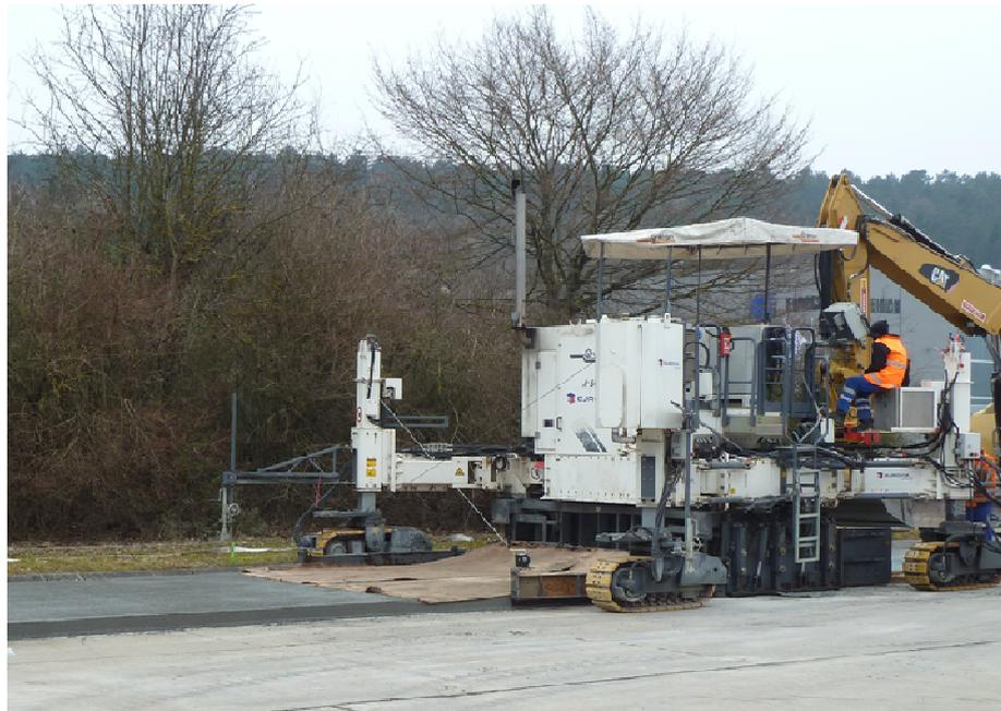
Abbildung II.1.20: Erfolgreicher Einbau der Deckschicht mittels Gleitschalungsfertiger
