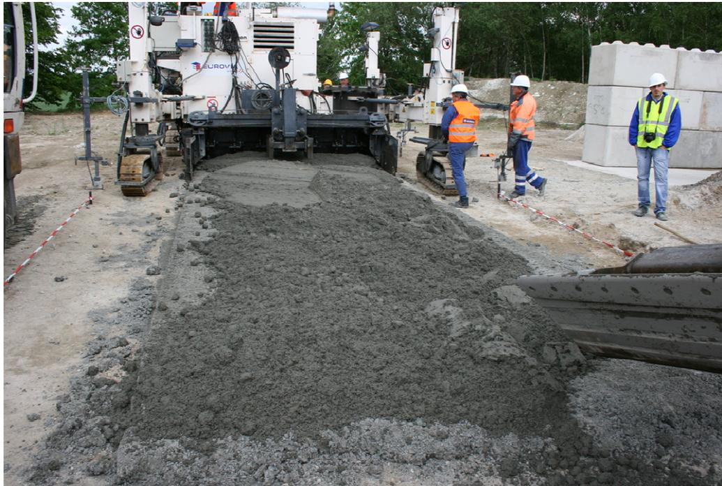
Bild D3: Einbau der Deckschichtmischungen
