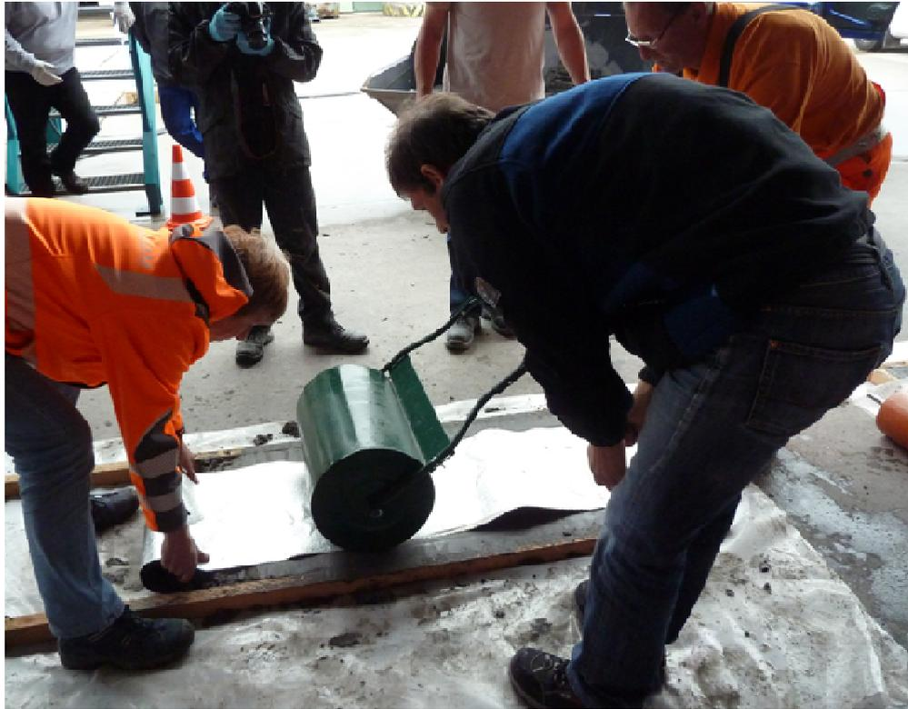
Bild D7: Prägung mit wassergefüllter Handwalze
