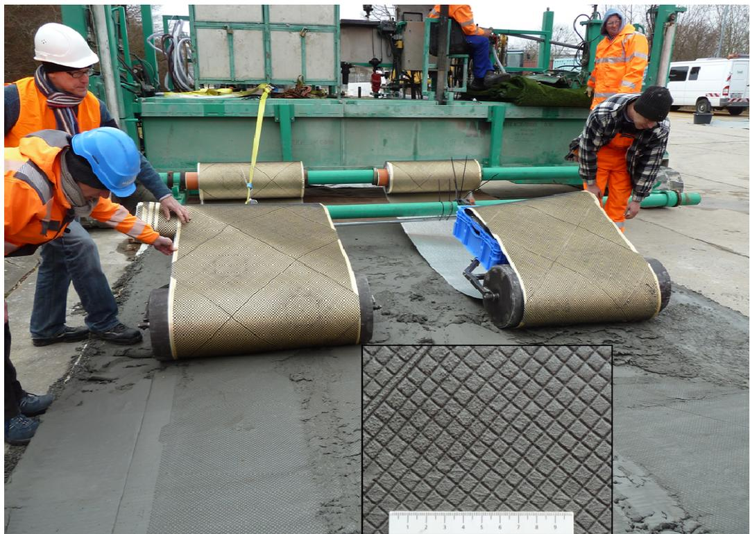
Bild D24: anschließende Prägung mit stabiler Textur (Walzenbreite: je 1 m, Walzengewichte: je 74 kg + Zusatzgewichte 60 kg auf der rechten Spur und 80 kg auf der linken Spur)
