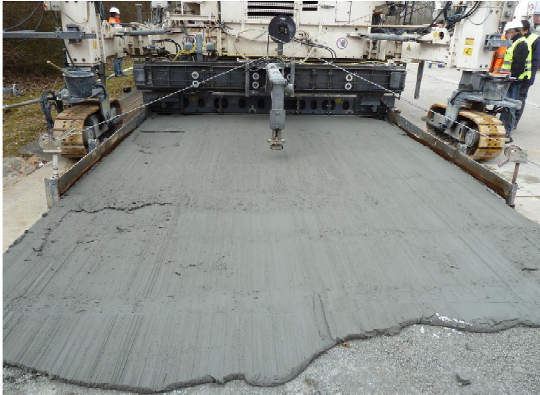
Bild D27: Einbau der Nutzschichtrezeptur auf Abschnitt VI
