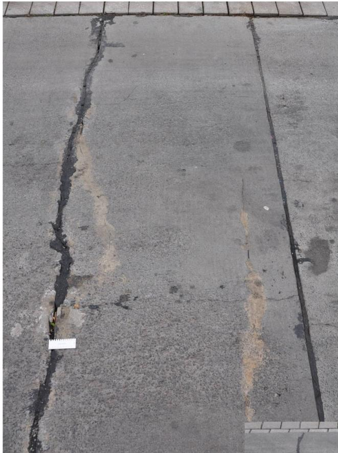
Bild D36: ausgeprägte Querrisse, z.T. nachgearbeitet und mit Bitumen verfüllt
