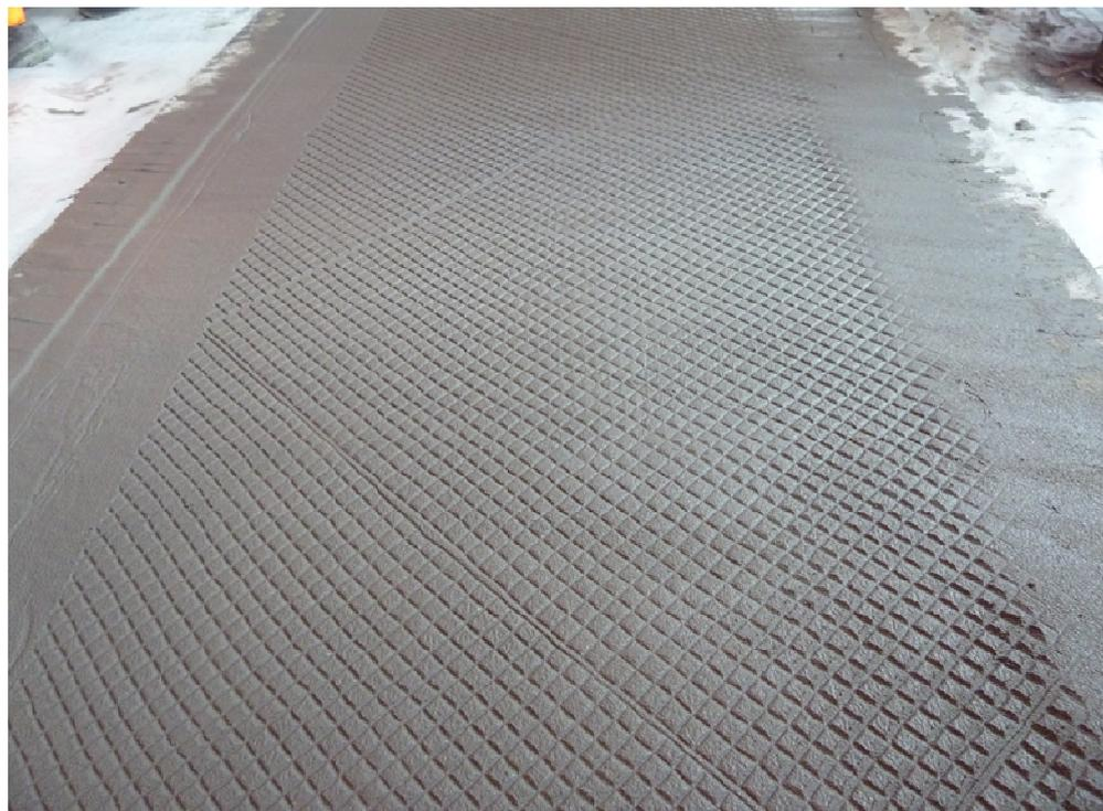
Bild D8: geprägte Oberfläche
