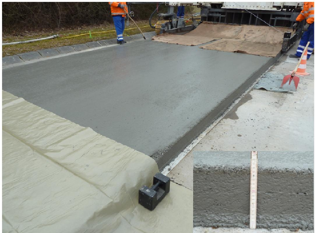
Bild D22: Abziehen mit Jutetuch
