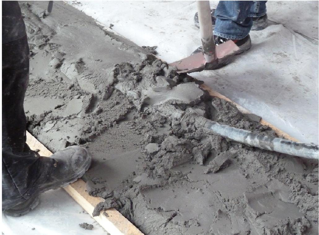
Bild D5: Verdichtung der Nuttschicht mit dem Innenrüttler
