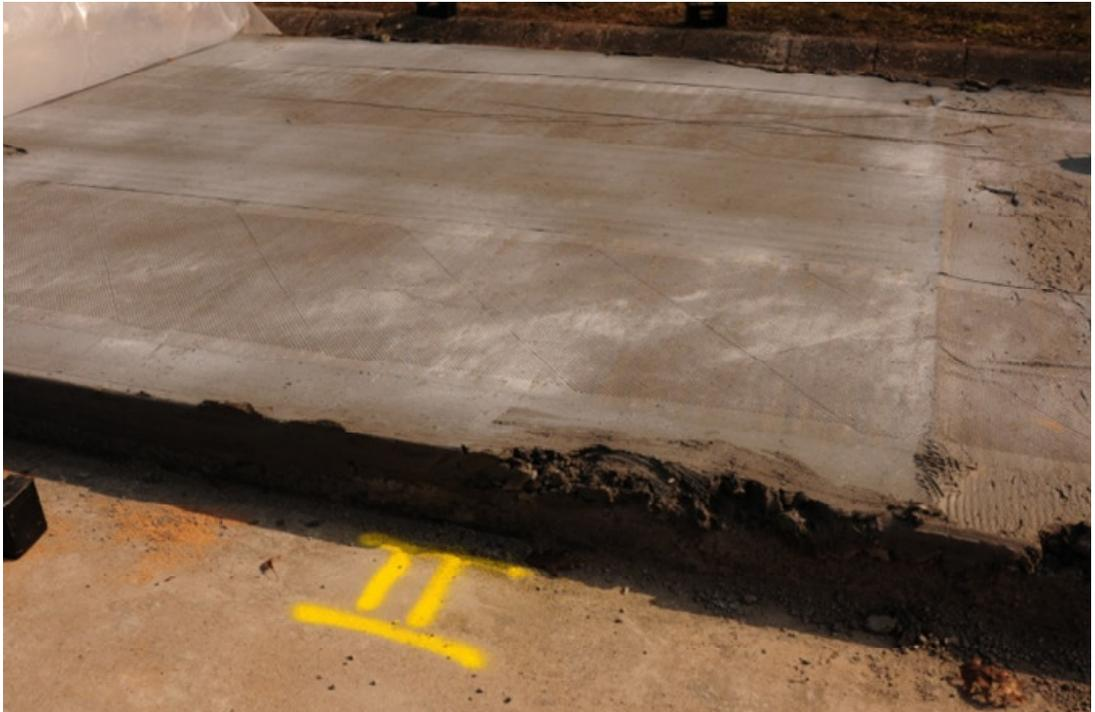
Bild D29: Abschnitt II (geänderte Nuttschichtmischung; Erhöhung des Wassergehaltes um 3,5 M.-%)
