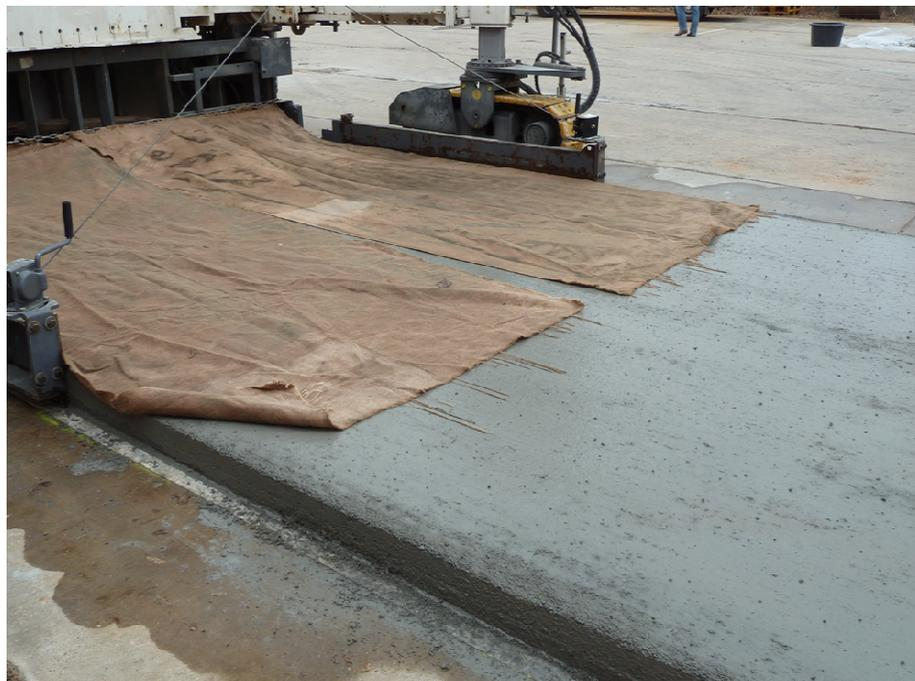
Abbildung II.1.21: Anschließendes Abziehen mit Jutetuch
