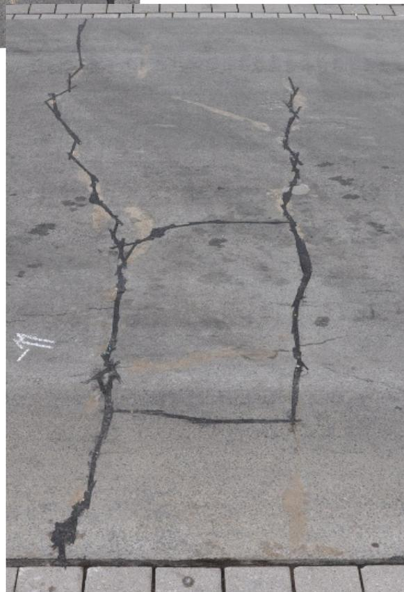
Bild D37: Risse mit Bitumen verfüllt
