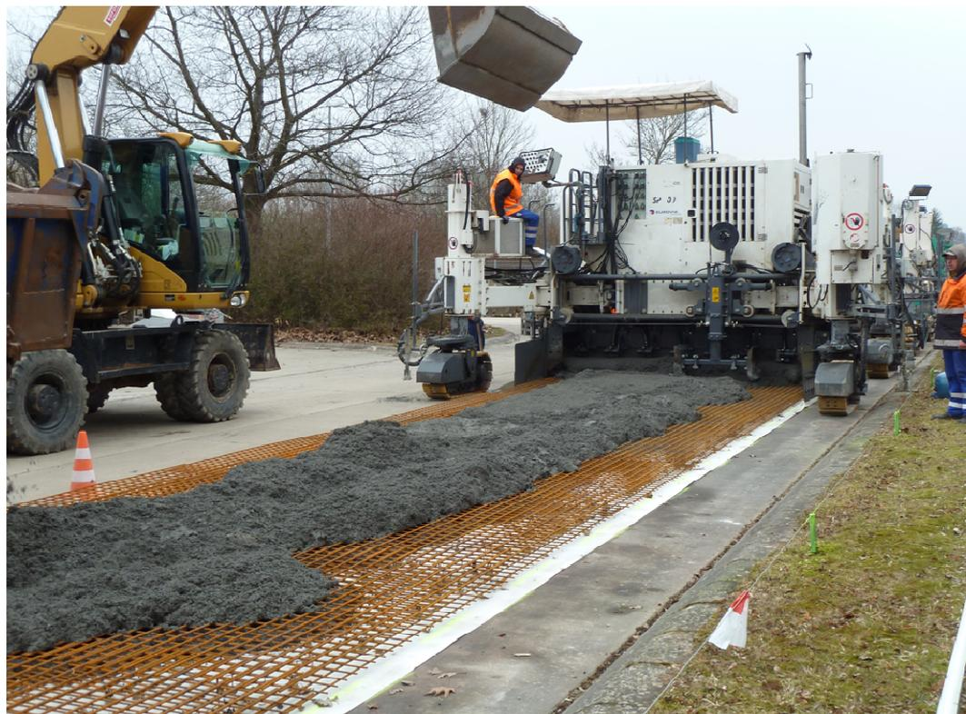
Bild D18: Beginn des Deckschichteinbaus
