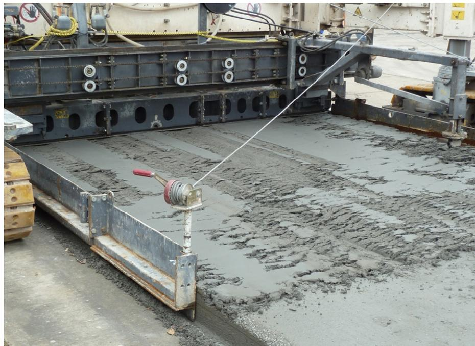
Abbildung II.1.22: Nuttschichteinbau
