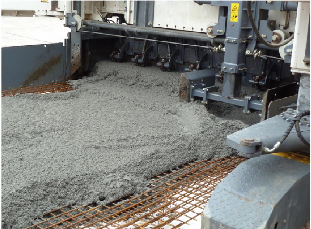
Bild D19: Deckschicht vor dem Verteilerschwert des SP 500
