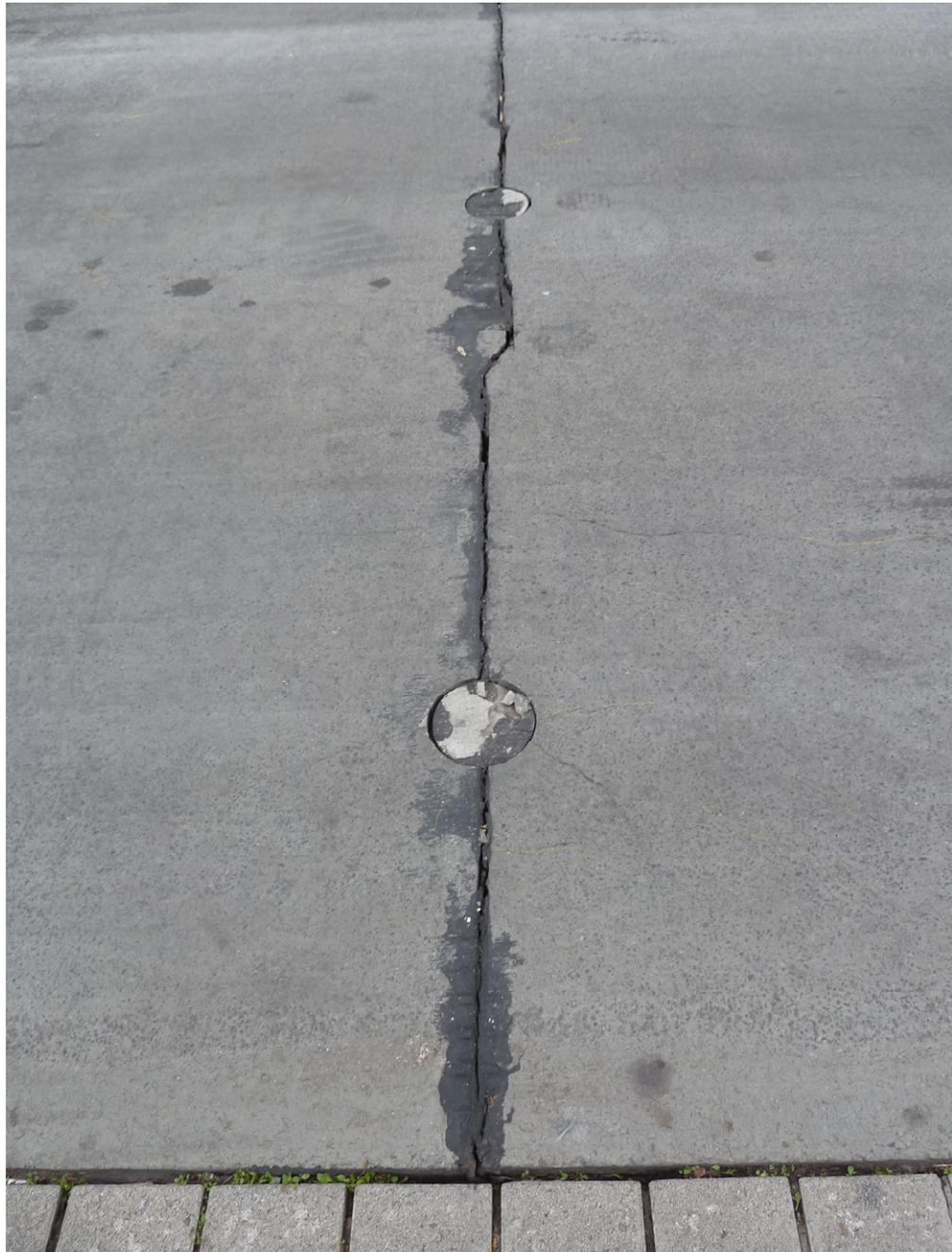
Bild D31: breiter Querriss mit zwei entnommenen Bohrkernen
