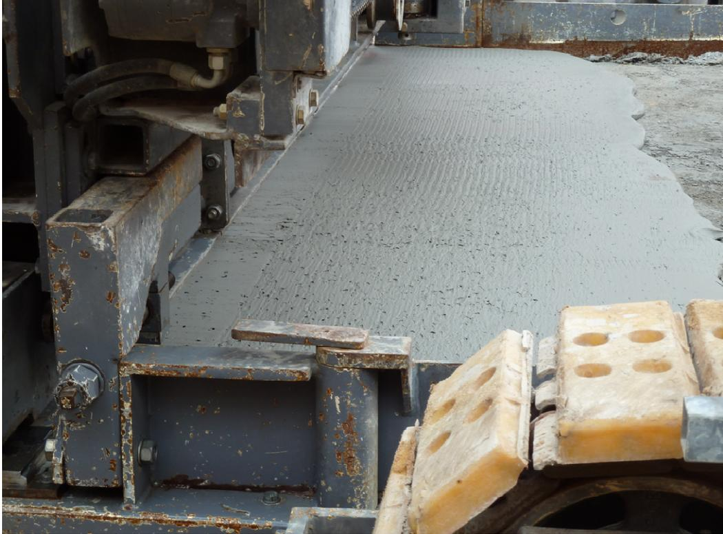
Bild D25: Die geänderte Nutzschichtrezeptur (Erhöhung des Wassergehaltes um 3,5 M.-%) lässt sich mit dem Fertiger einbauen...
