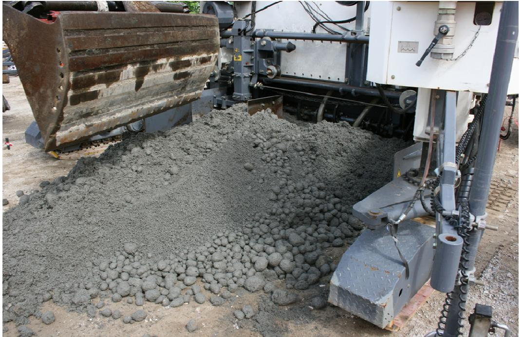
Bild D1: Deckschichtmischung aus dem OAT Fahrmischer
