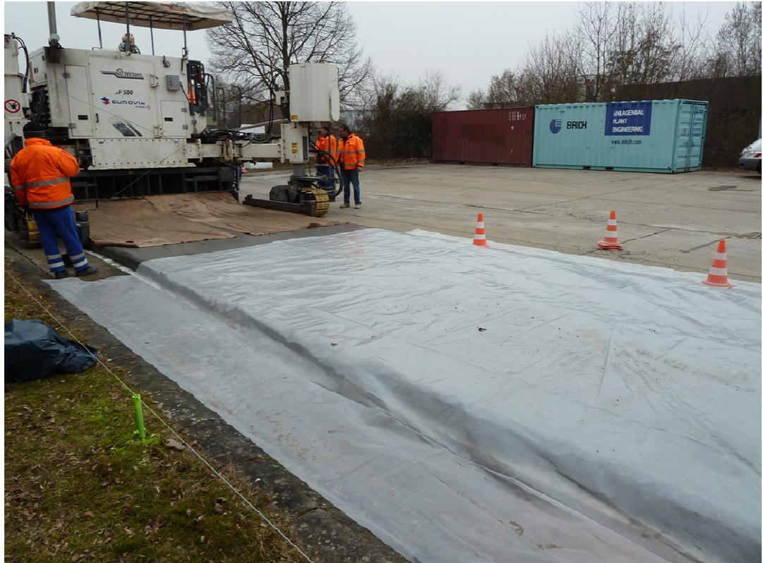
Bild D21: Mit Folie abgedeckte Deckschicht vom 03.04.13
