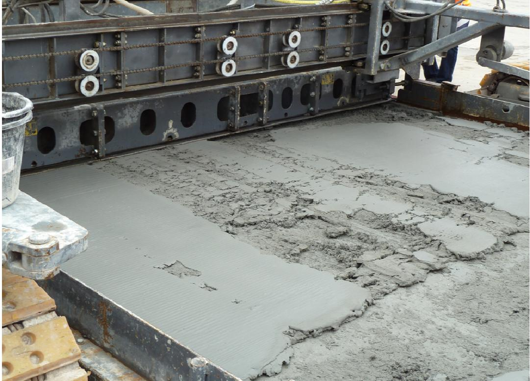
Bild D23: Originalmischung M5 nur mit unzureichendem Deckenschluss einbaubar
