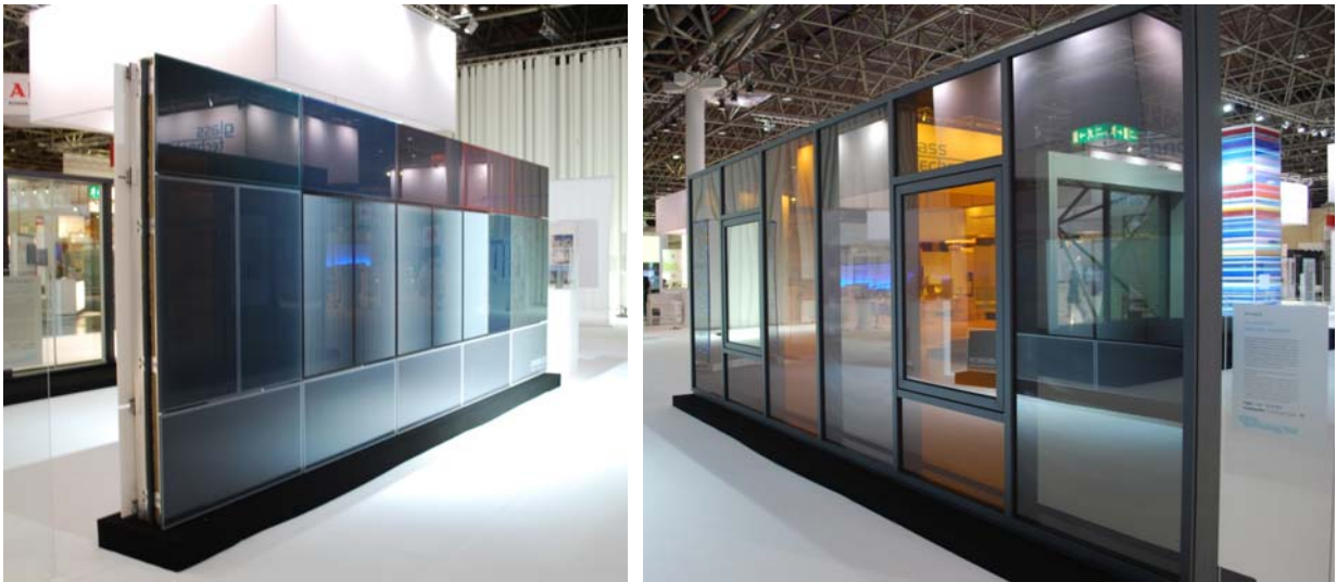
Abbildung 8-11: vorgehängte hinterlüftete PV-Fassade (links) und Pfosten-Riegel-Fassade auf der Glasstec 2012
