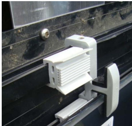
Abbildung 7-6: Klammergehaltene Konstruktion mit entsprechender Aluminium-Unterkonstruktion
