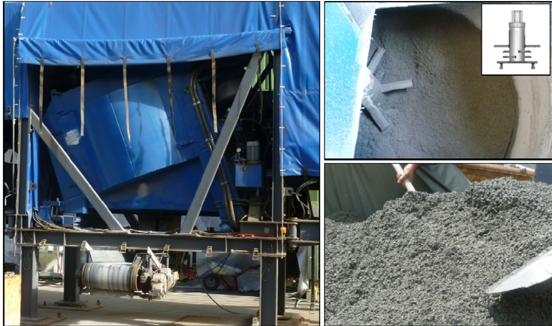
Abbildung 16: Mischversuche zur Herstellung der Deckschicht am 17.- 18.07.12 bei der Fa. Eirich. Eirich-Intensivmischer, Modul R24 (links), Blick in den Mischbehälter (oben rechts) und Deckschichtmischung unmittelbar nach Ende des Mischprozesses
