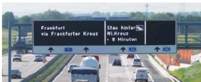
Intelligente Straße: Dynamische Wegweisung mit integrierten Stauinformationen (dWiSta) am Wiesbadener Kreuz.
