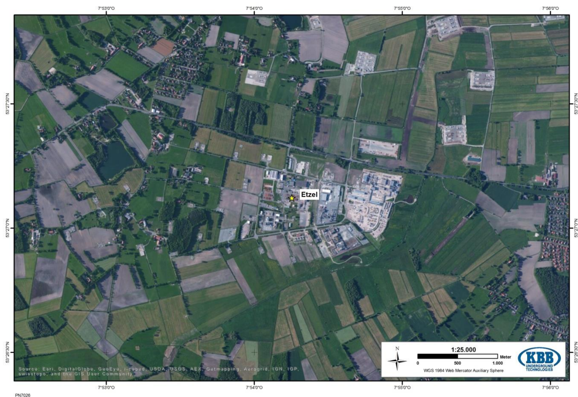
Abbildung 3-35: Lage des Ölspeichers Etzel der IVG
