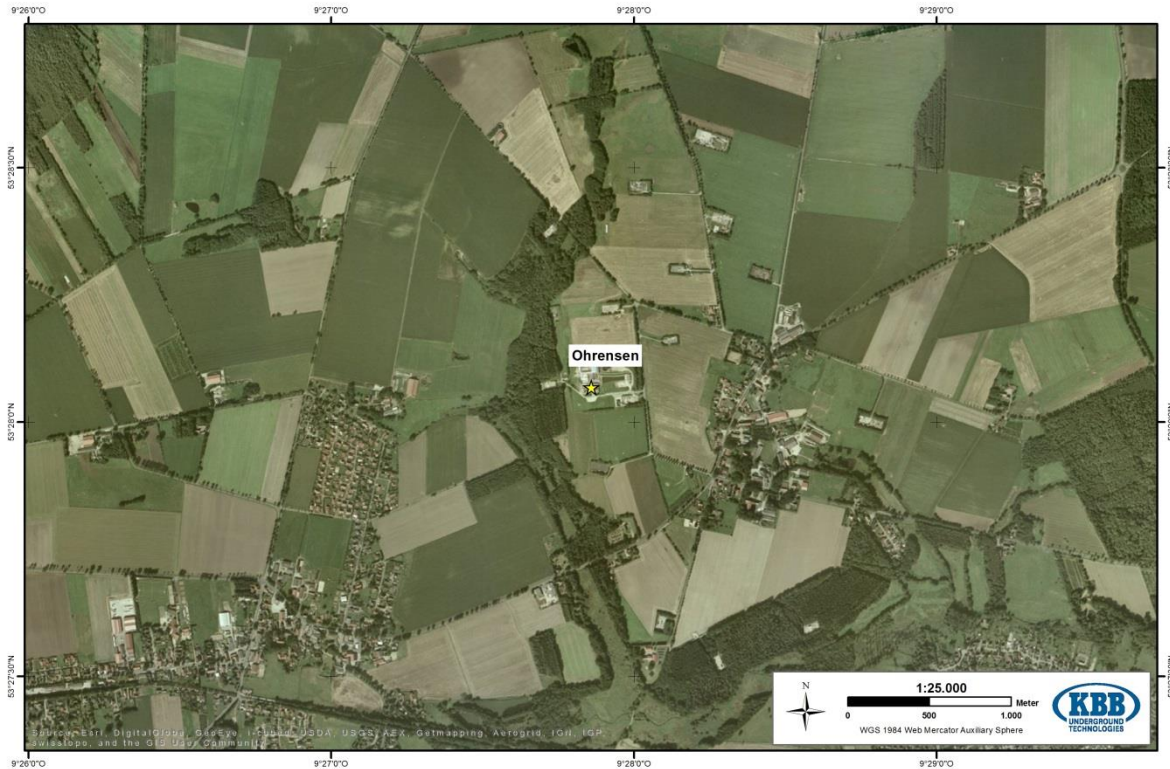
Abbildung 3-37: Lage des Flüssiggas-Speichers Ohrensen der DOW
